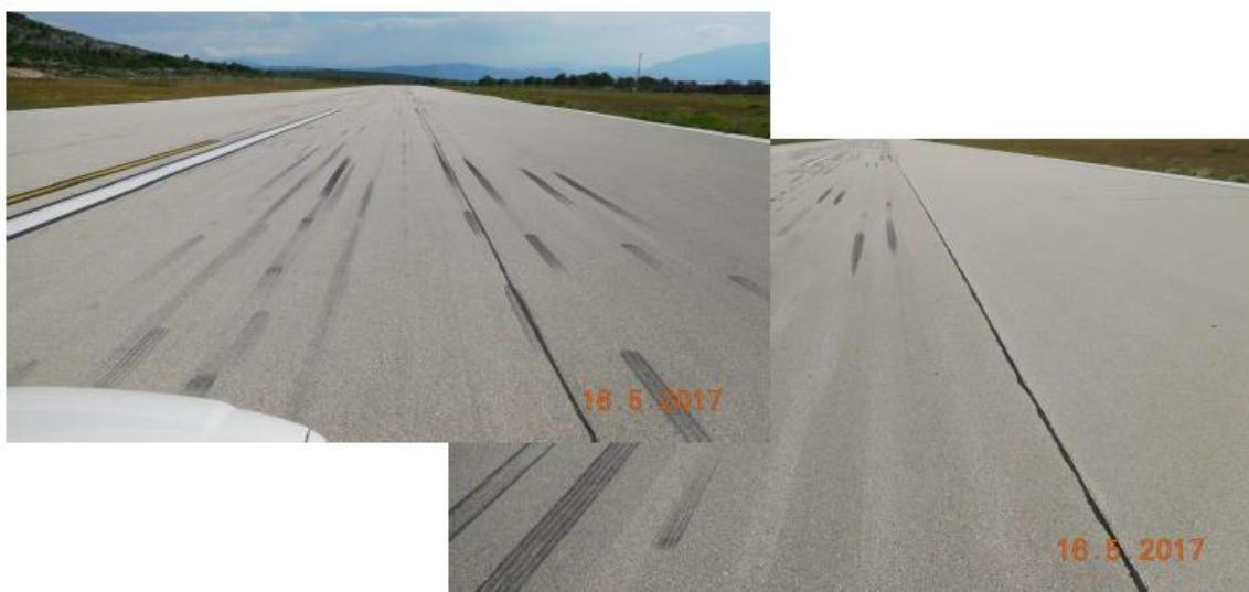
Slika 2.7 Otvoreni uzdužni radni spojevi, zapunjeni masom za zalijevanje (Izvor: Građevinski projekt)
