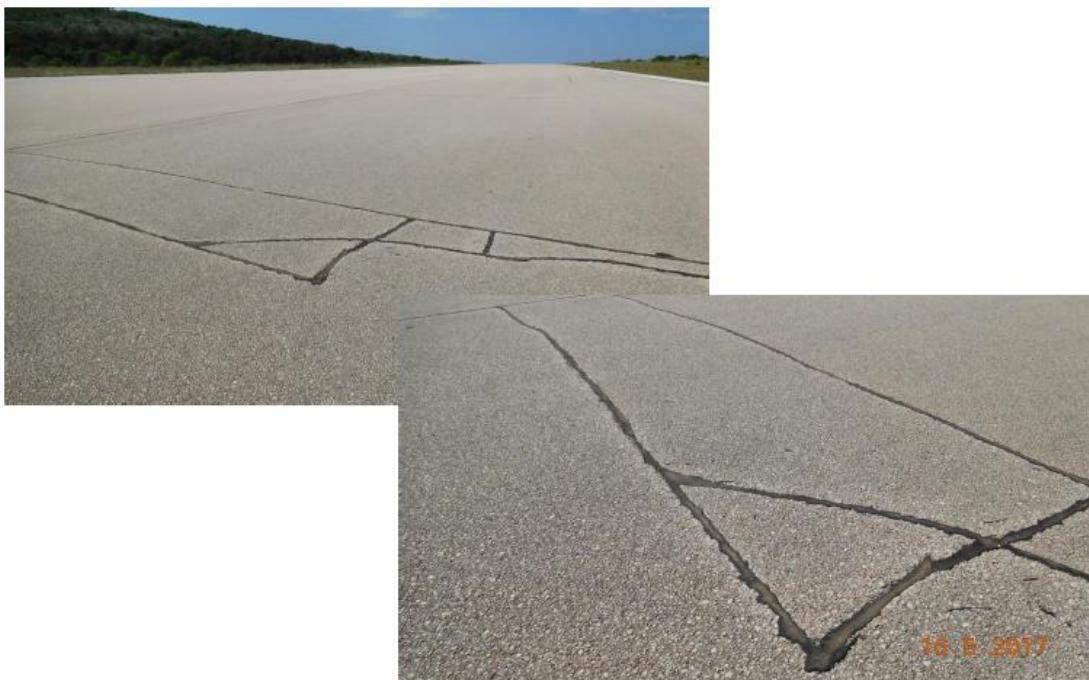
Slika 2.9 Poprečna pukotina nastala uz otvoreni radni spoj na postojećoj uzletno-sletnoj stazi (Izvor: Građevinski projekt)
