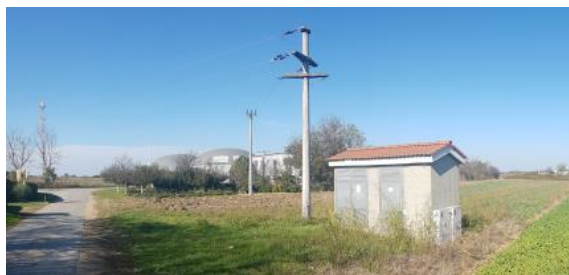
Slika 64. Pogled na TS i objekt gospodarske namjene na rubnom dijelu naselja Virje
