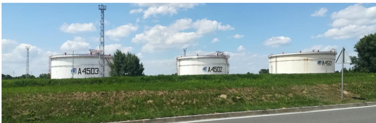
Slika 69. Pogled s D210 istočno od Terminala (s dionice koja prolazi paralelno uz NT) u smjeru zapada na spremnički prostor (T2)
