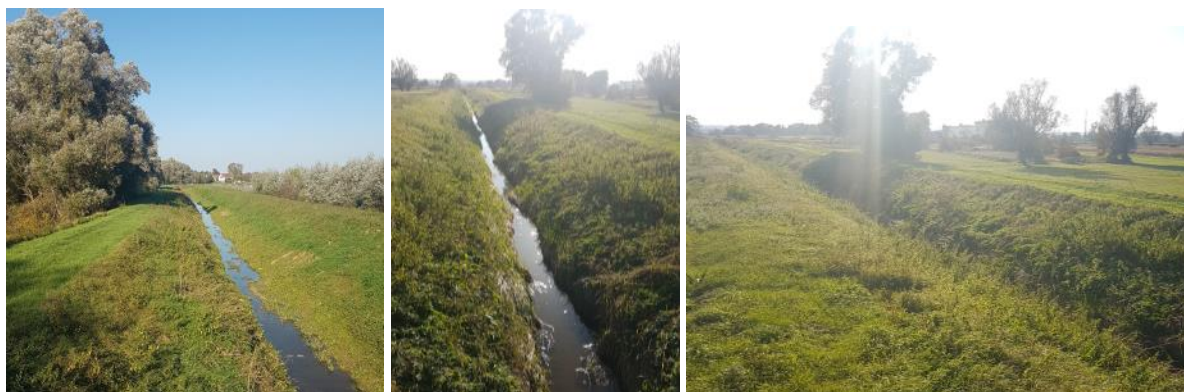
Slika 63. Pogled na kanalizirani vodotok Zdelju na središnjem dijelu područja s mosta lokalne ceste
