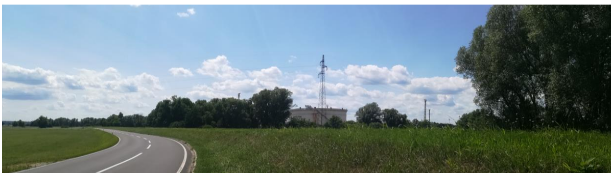
Slika 71. Pogled s D210 sjeveroistočno od NT u smjeru JZ na spremnički prostor (T4)
