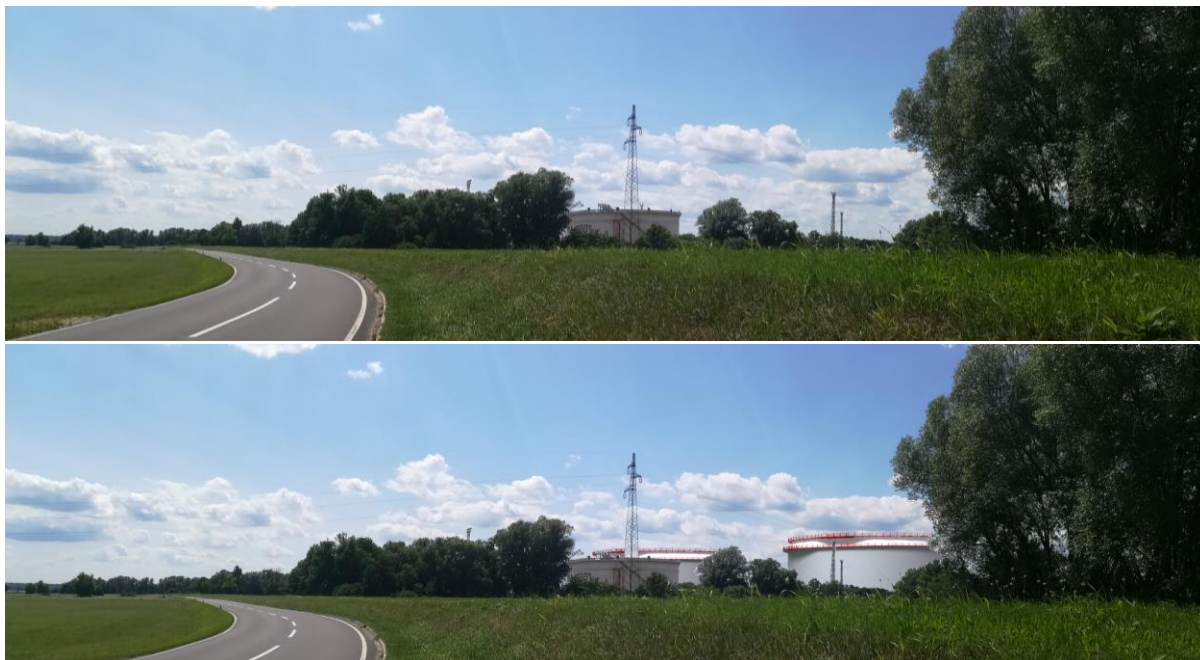
Slika 89. Pogled s D210 sjeveroistočno od NT u smjeru JZ na spremnički prostor – prije (gore) i poslije (dolje) izgradnje zahvata
