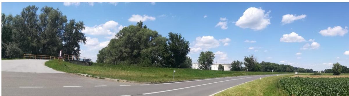
Slika 68. Pogled s križanja pristupne ceste do NT i državne ceste D 210 na Terminal (T1)
