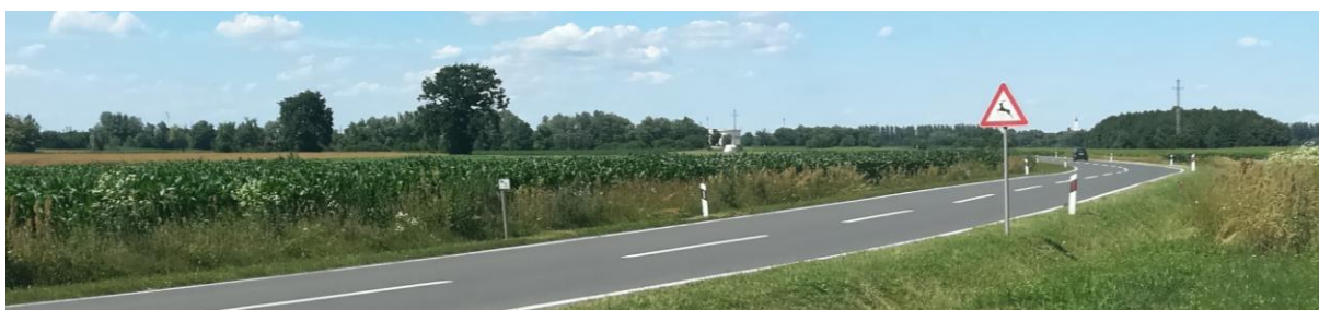
Slika 76. Pogled s D210 uz ugostiteljski objekt (južno od NT) u smjeru sjevera na spremnički prostor (T9)
