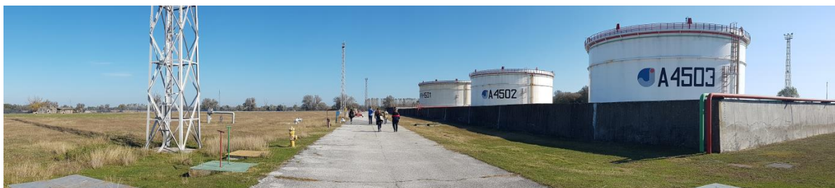
Slika 67. Pogled sa središnje ceste NT Virje u smjeru SI na spremnički prostor (desno) i površinu planiranog zahvata (lijevo), (T0)
