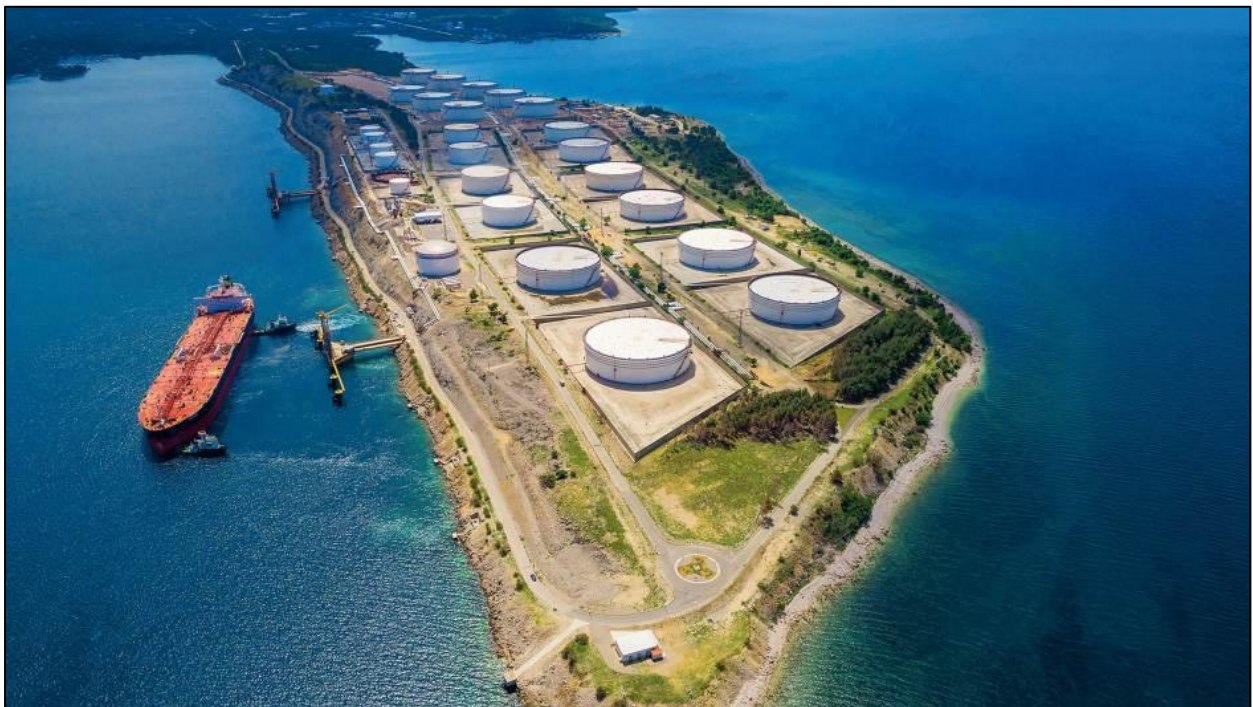
Slika 1. Pogled na postojeći Terminal Omišalj (Izvor: JANAF d.d.)
