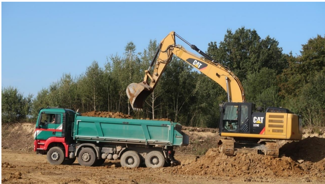
Slika 3. Primjer otkopavanja i utovara
