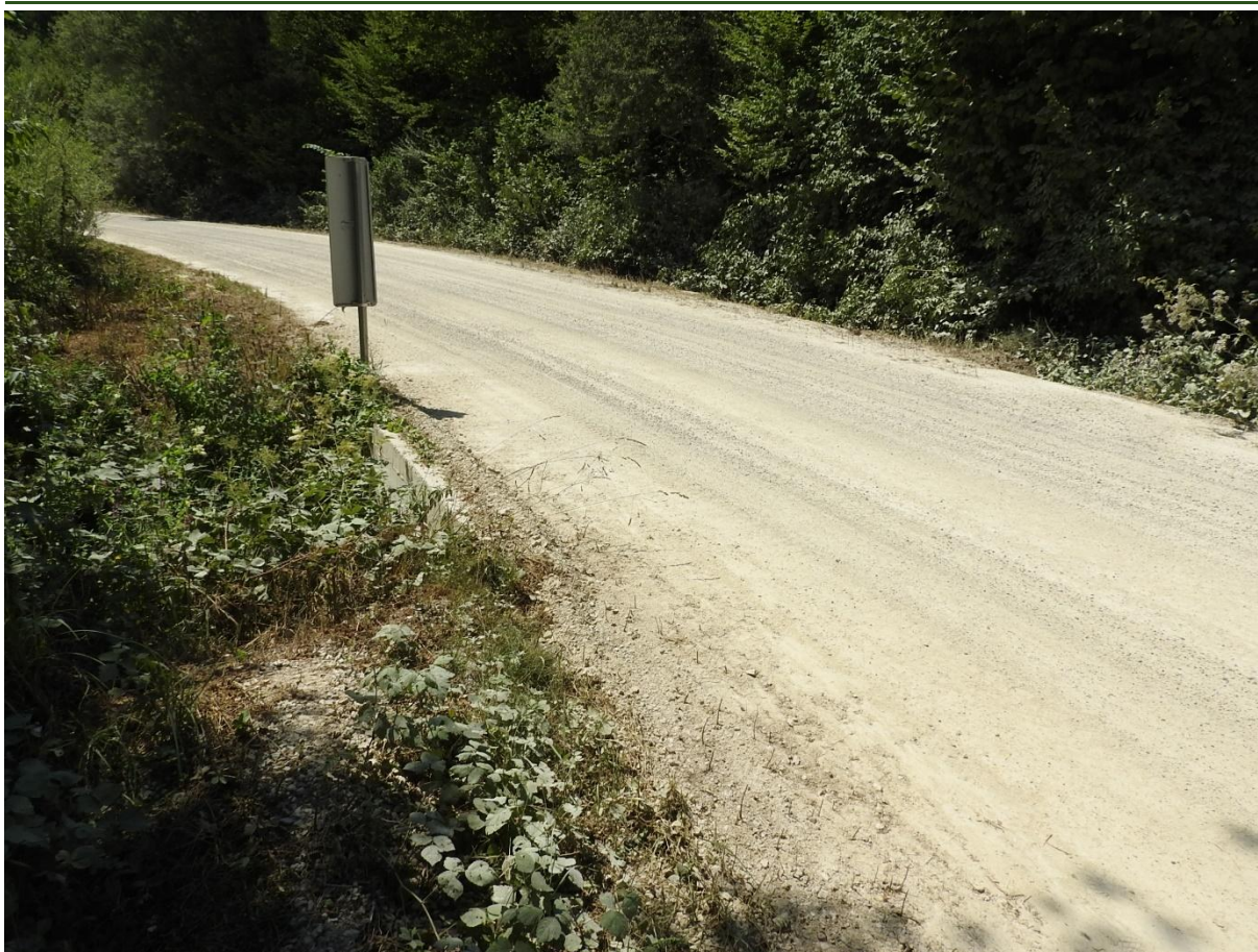
Fotografija 1-22: Točka 13: Postojeći propust
