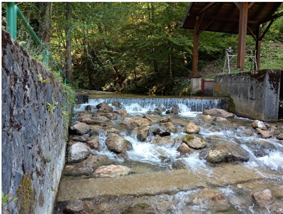
Fotografija 1-5: Bregana na lokaciji Bregana 9. vidljiva riječna stepenica s nabačajem kamenja
