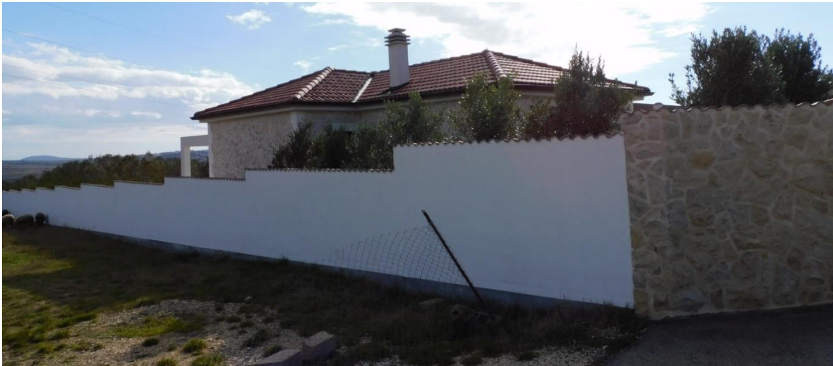
Fotografija C-22: Pojedinačna kuća preko čijeg ruba prelazi glavna os 2 kod stacionaže 1+450 - lokacija fotografije R28 Izvor: Obilazak terena
