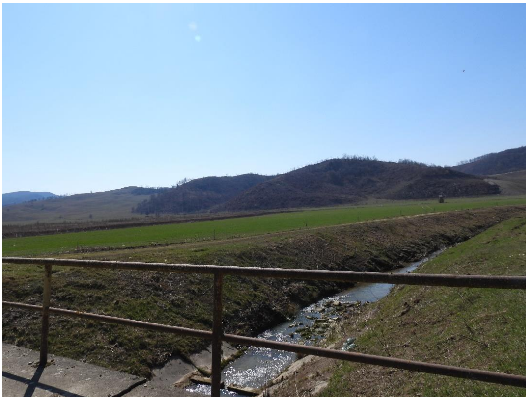
Slika 4.8-4 Most preko vodotoka Subocke kod stacionaže km 3+610 (Izvor: Terenski obilazak, Oikon d.o.o.)
