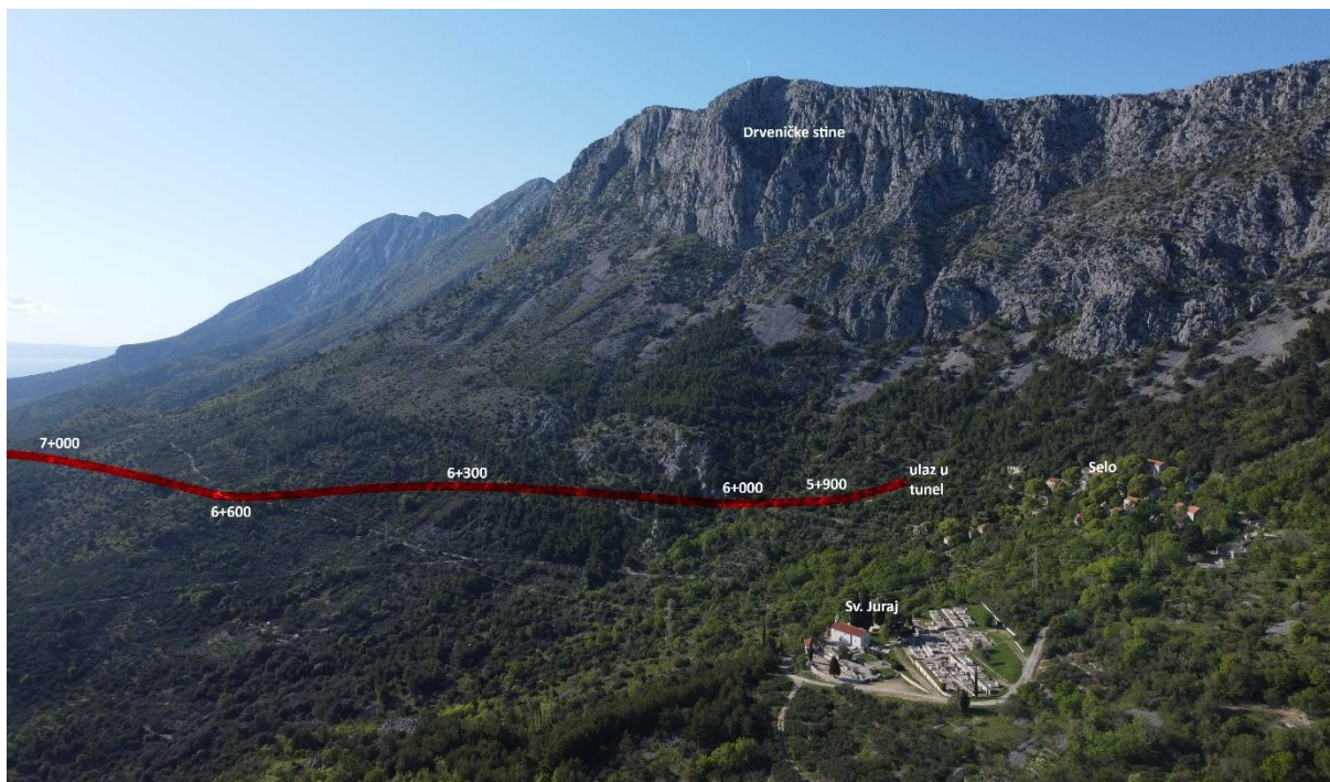
Fotografija C-13: Prikaz koridora planiranog zahvata između stacionaže 5+840 i 7+000
