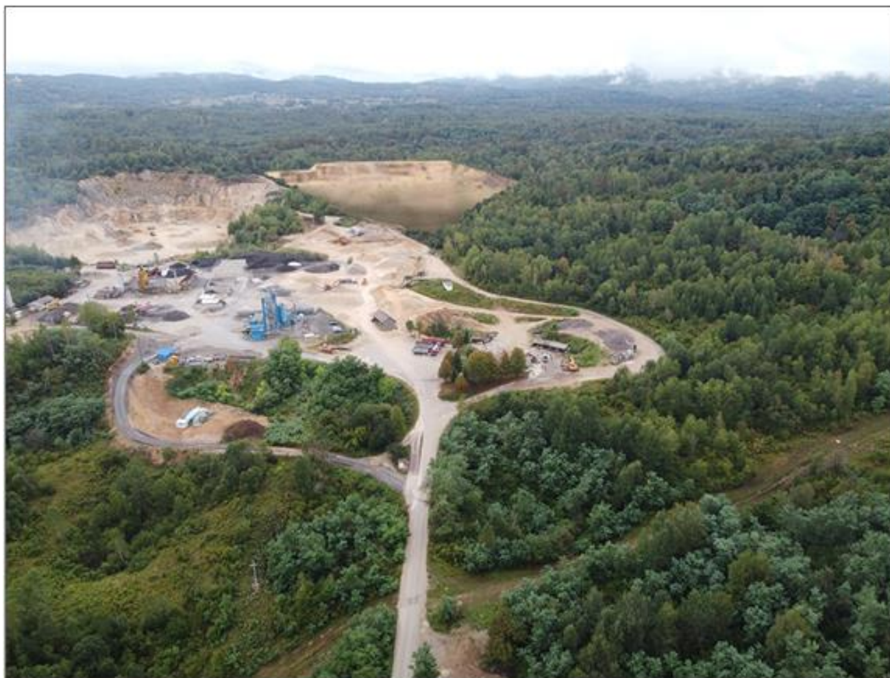
Slika 4./8. Pogled na EP u smjeru sjeverozapada [44]
