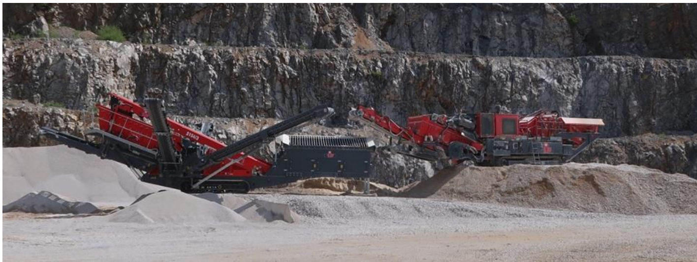
Slika 1./12. Oplemenjivačko postrojenja (primjer)
