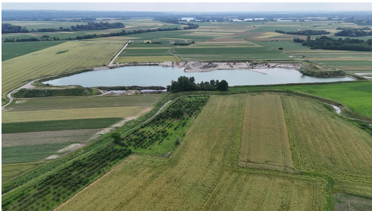
Slika 1./6. Postojeće stanje – pogled P3
