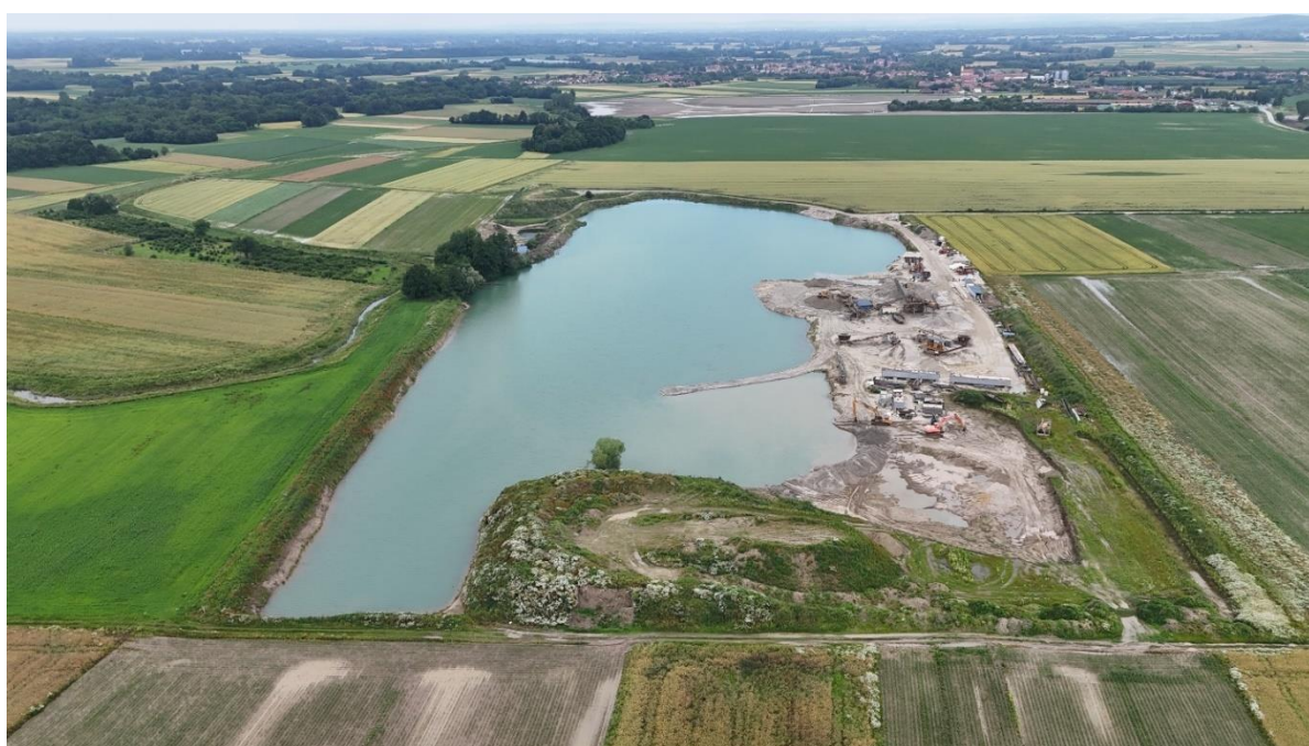
Slika 1./7. Postojeće stanje – pogled P4
