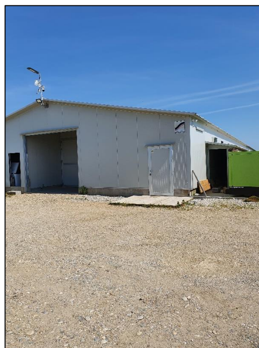
Ulazi u postojeći objekt na lokaciji zahvata
