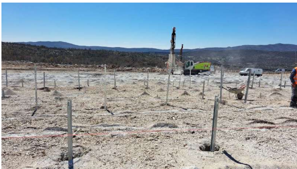
Grafički prikaz B-17: Primjer temeljenja na terenu sličnih karakteristika kao kod planirane SE Kozjak
