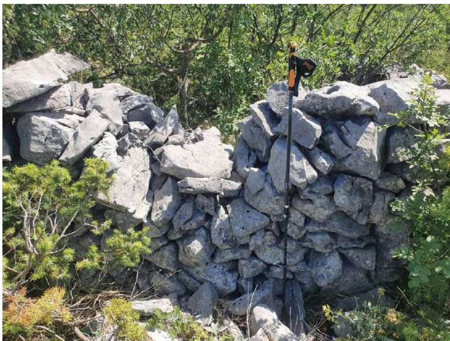
Grafički prikaz C-112: Detalj sjevernog dijela kompleksa suhozida u zapadnom dijelu zahvata visine 1,2 m s mjerkom
