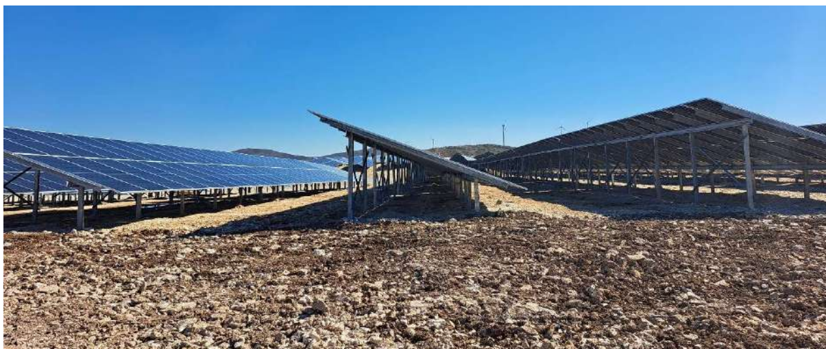
Grafički prikaz B-13: Primjer uređenja tla ispod modula sunčane elektrane na terenu sličnih karakteristika
