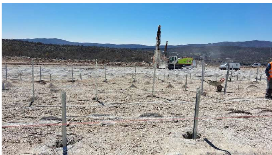
Grafički prikaz A-6: Primjer temeljenja na terenu sličnih karakteristika kao kod planirane SE Kozjak
