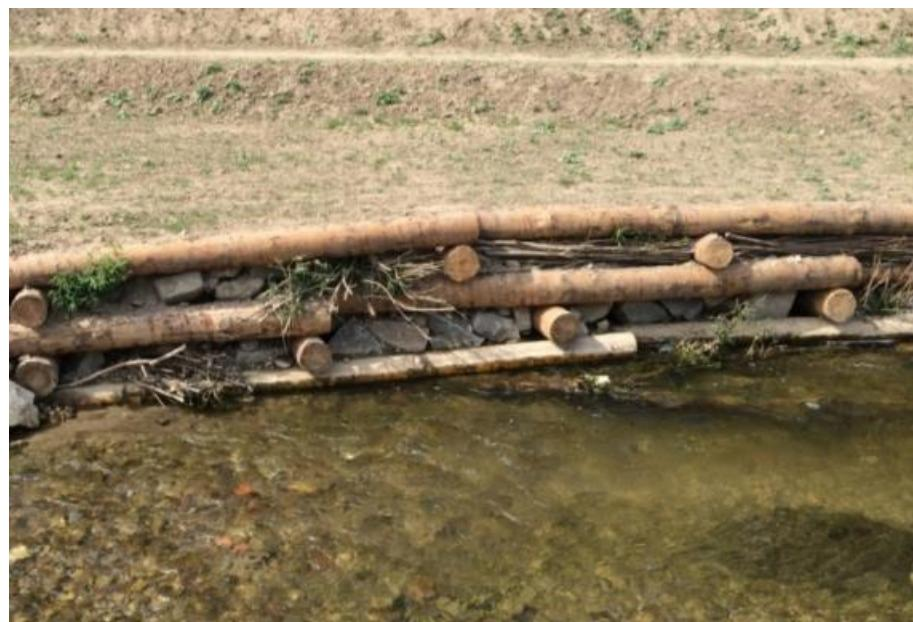
Slika 2-31 Biološka vodogradnja tipa drveni sanduci
