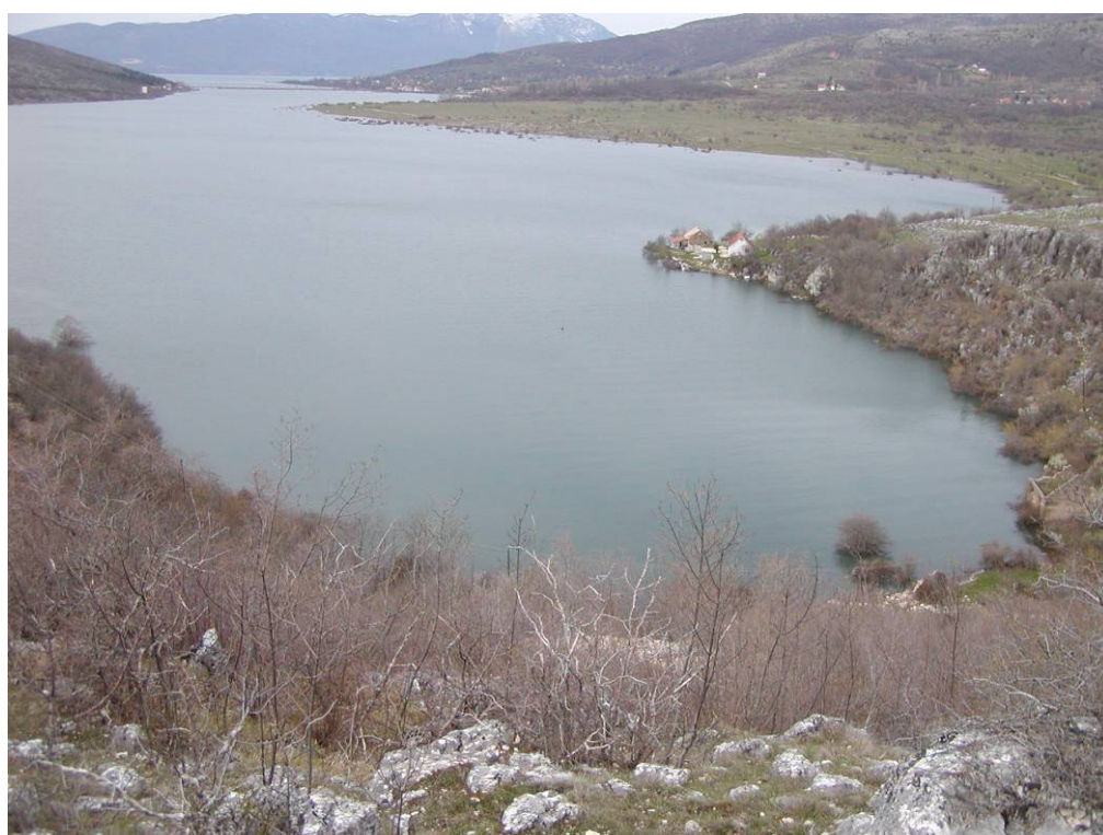
Slika 4.3.10 Područje strojarnice i donjeg bazena
