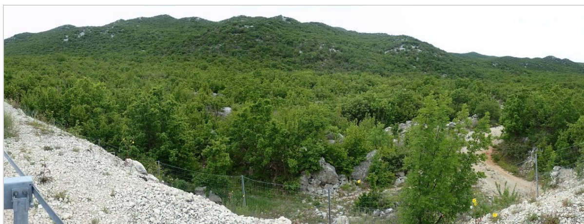
Slika 3.10.2-2. Pogled na lokaciju na kojoj je planirana izgradnja tunela s postojeće autoceste A1 (točka 3 na slici 3.10.2-6.)
