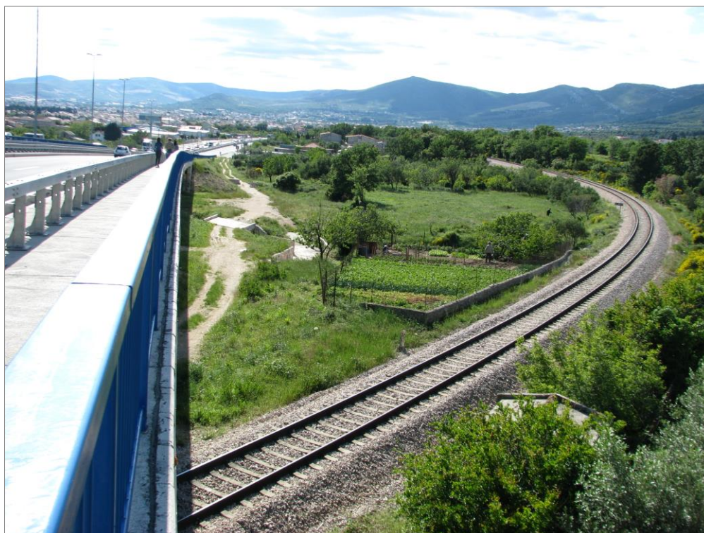
Slika 1.3.1.1-2. Pogled na željezničku prugu M604 u području čvora na DC8
