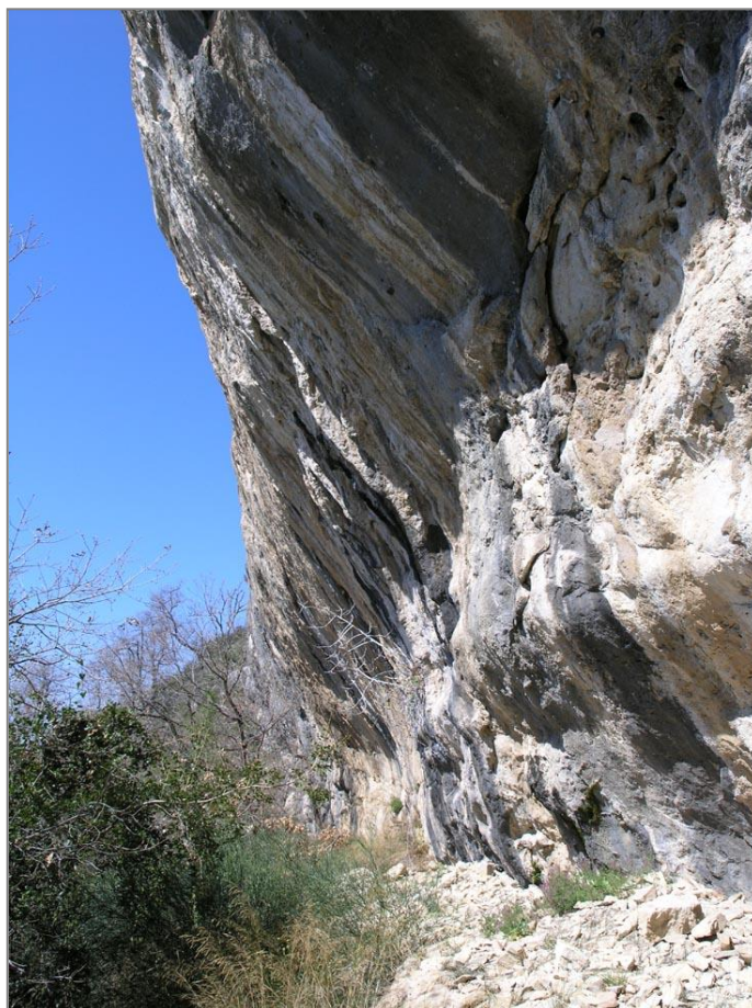
Slika 3.11.3-3. Pogled na abrij na položaju Meje između stacionaže 0+4000 i 0+4500
