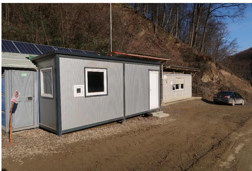
Slika 1./11. Kontejneri za smještaj radnika s mobilnim sanitarnim čvorom
