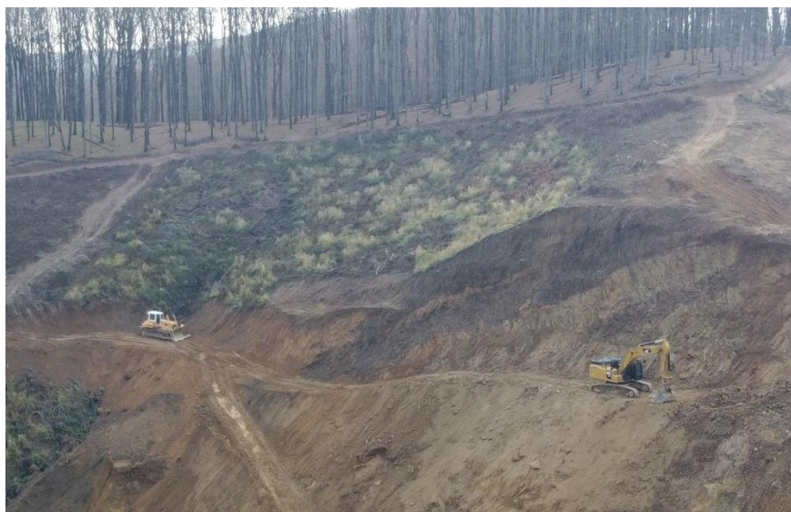
Slika 1./12. Buldozer i bager u radu na etaži
