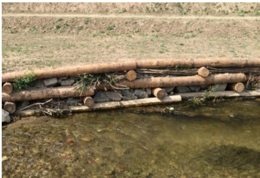
Slika 2-31 Biološka vodogradnja tipa drveni sanduci
