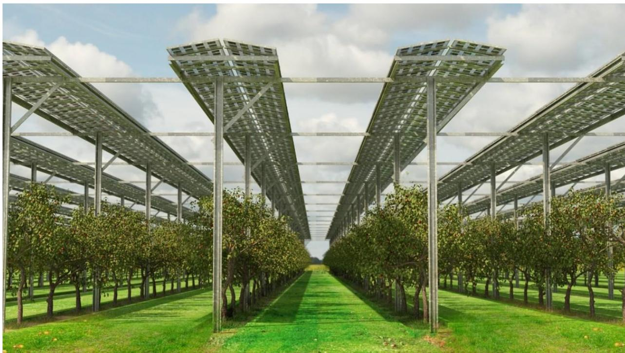
Slika 2.14 Primjer postavljanja solarnih modula iznad redova stabala nasada (Izvor: Idejno rješenje)
