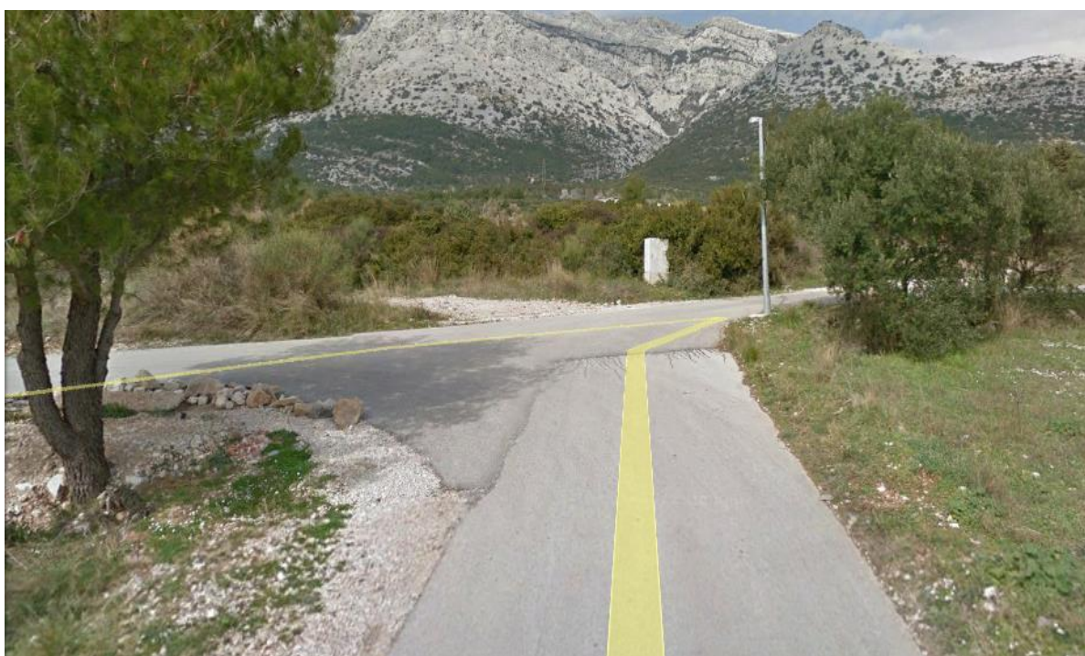
Slika 3.10.2.-2. Pogled na lokaciju podvožnjaka Trstrnice (točka 2)
