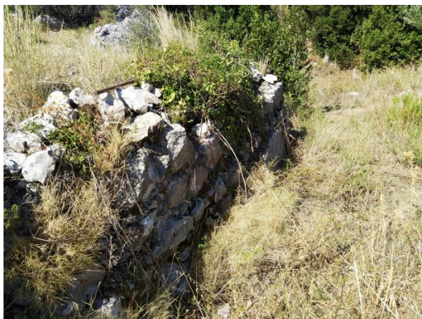
Slika 3.11.-11. Dio sjevernog temelja zida stražarnice Toretta
