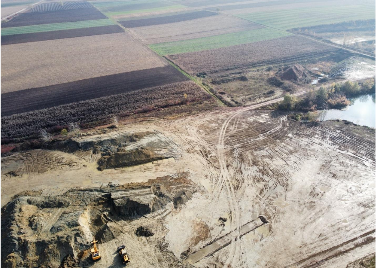
Slika 1./5. P3 – pogled sa jugozapadnog dijela tvornice prema sjevernom dijelu eksploatacijskog polja
