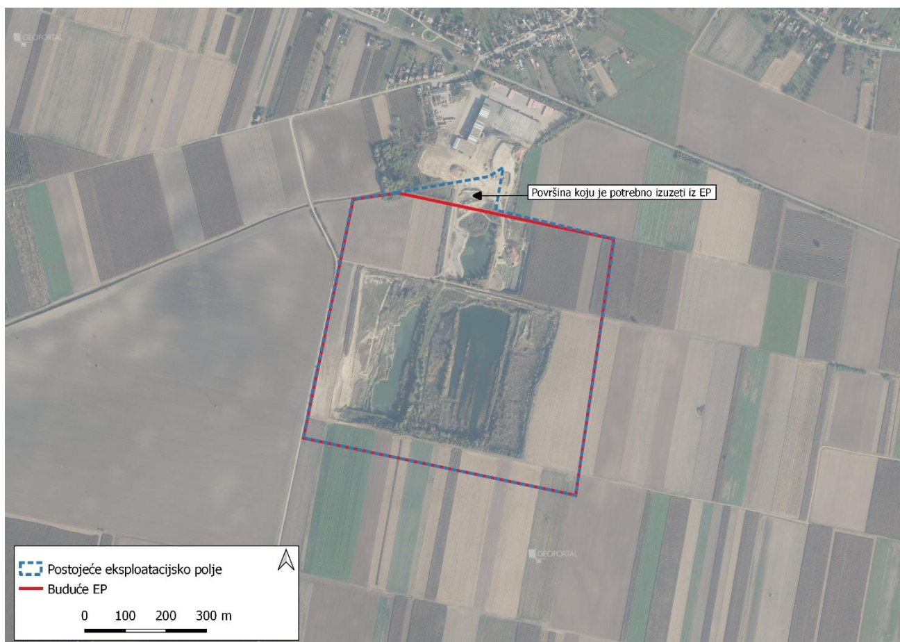
Slika 1./1. Ortofoto snimak postojećeg stanja s označenim pogledima na površinski kop
