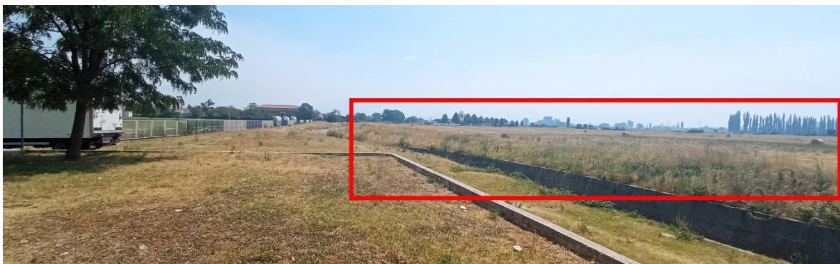
Fotografija A-2: Raskrižje 3 u km 0+685 – lokacija raskrižja 4 i pločastog propusta
