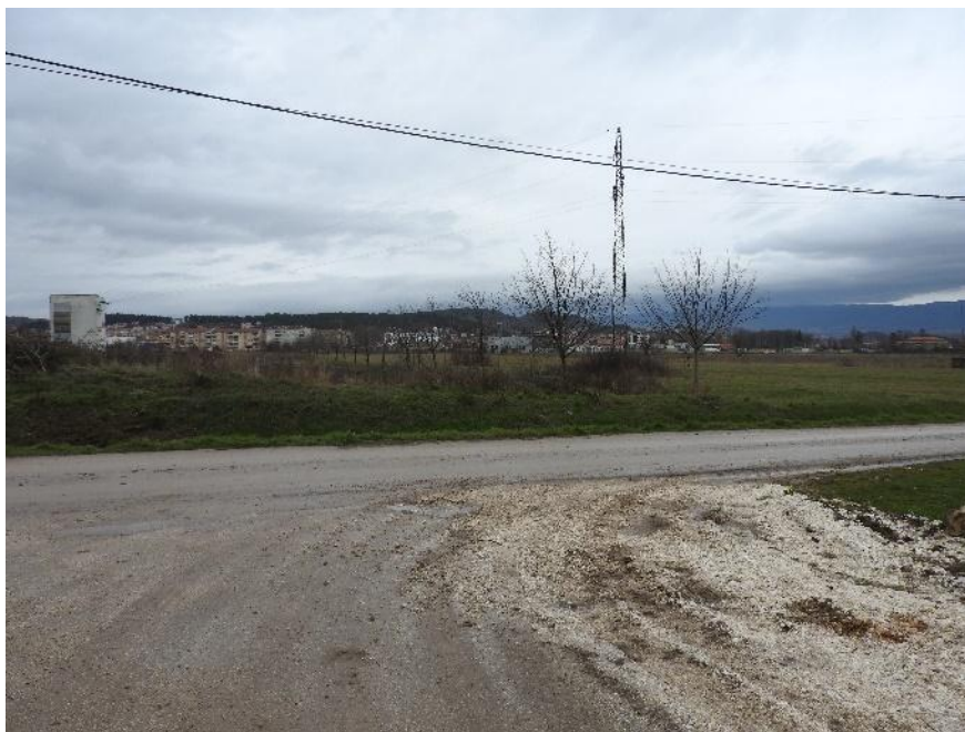
Fotografija C-25: Točka 2 – Postojeće antropogeno i izgrađeno stanište (postojeća prometnica) na planiranom kružnom raskrižju oko stacionaže 0+400
