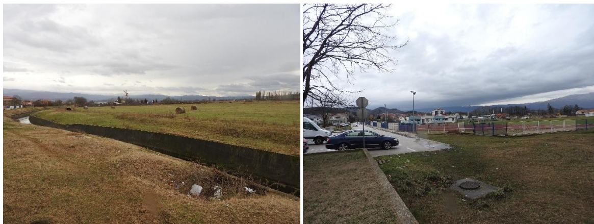
Fotografija C-3: Točka 3 (oko stacionaže 0+725) – lokacija planiranog pločastog propusta i raskrižja; Ćosin potok (lijevo) i kraj postojeće prometnice (desno)
