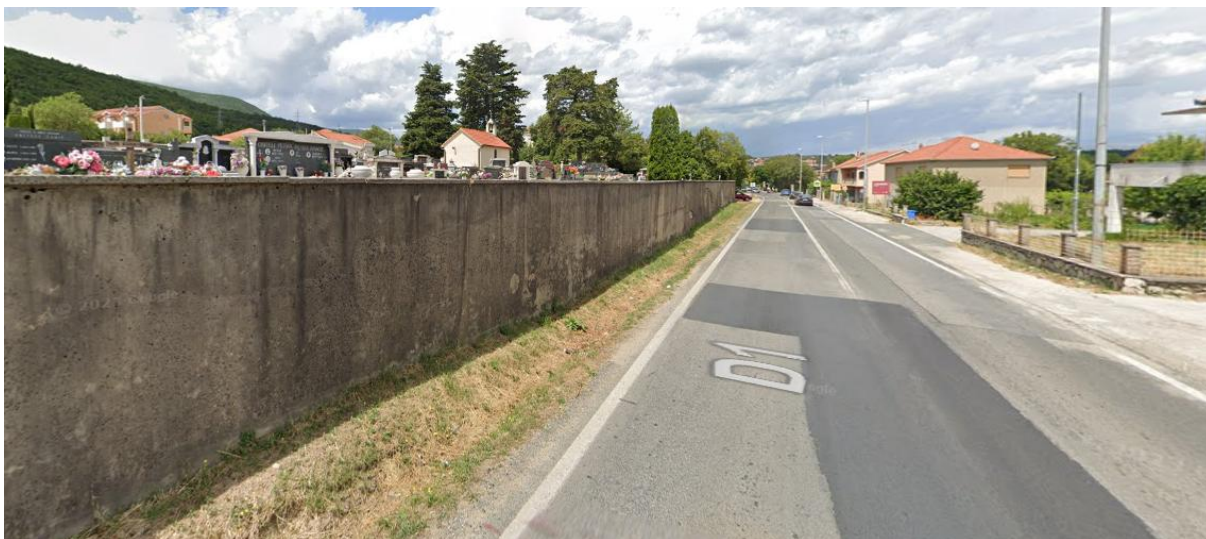
Fotografija D-1: Groblje uz državnu cestu DC1 na početku trase spojne ceste Izvor: Google Maps
