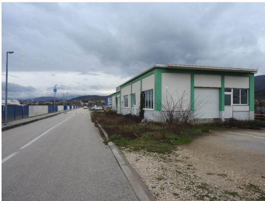
Fotografija C-27: Točka 4 – Izgrađeno i industrijsko stanište u obliku postojeće prometnice oko stacionaže 0+950, pogled na trasu u smjeru juga Izvor: Terenski obilazak
