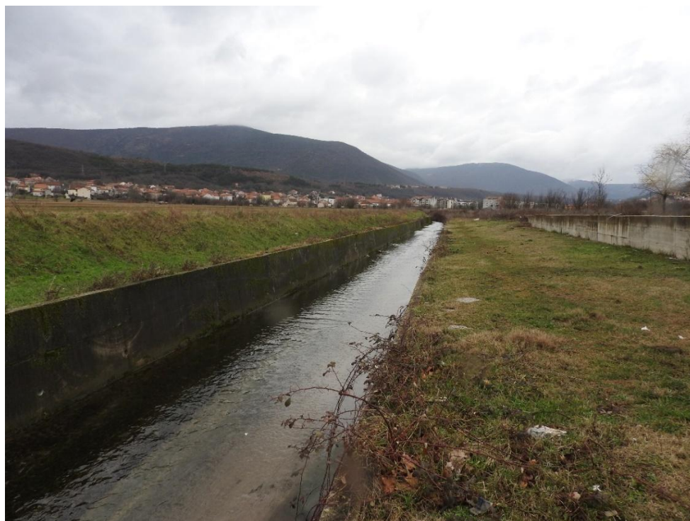
Fotografija C-42: Vodeno stanište - kanalizirani Čosin potok s betoniranom obalom te okolnim travnjačkim staništem, pogled prema zapadu, oko stacionaže 0+750
