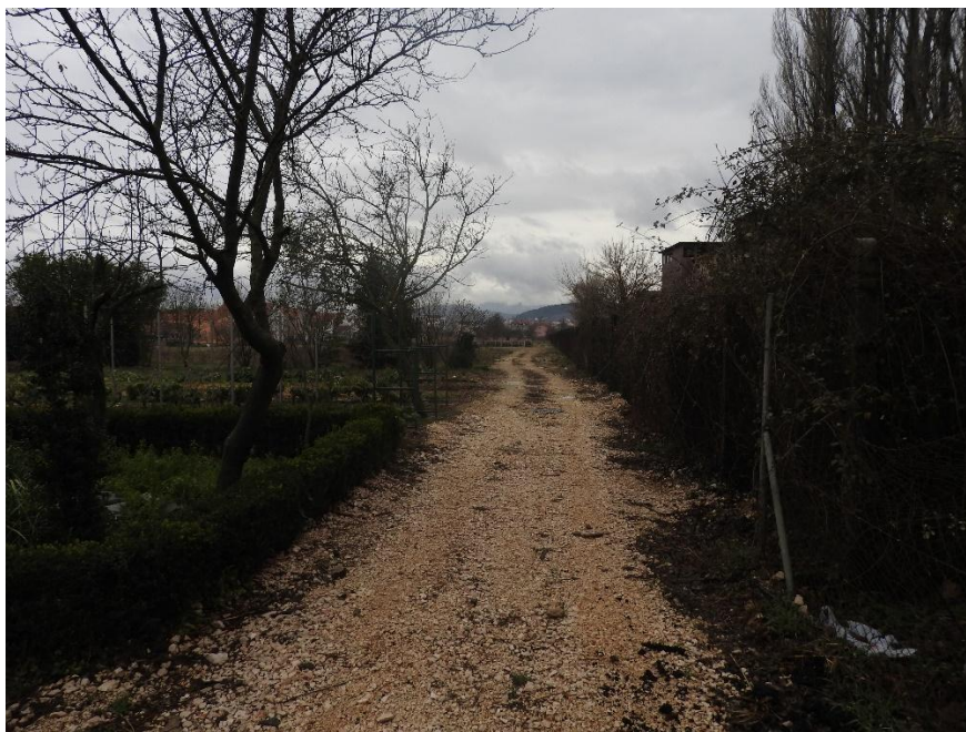
Fotografija C-31: Točka 8 – Makadamski put oko stacionaže 1+550, pogled na trasu prometnice u smjeru juga Izvor: Terenski obilazak
