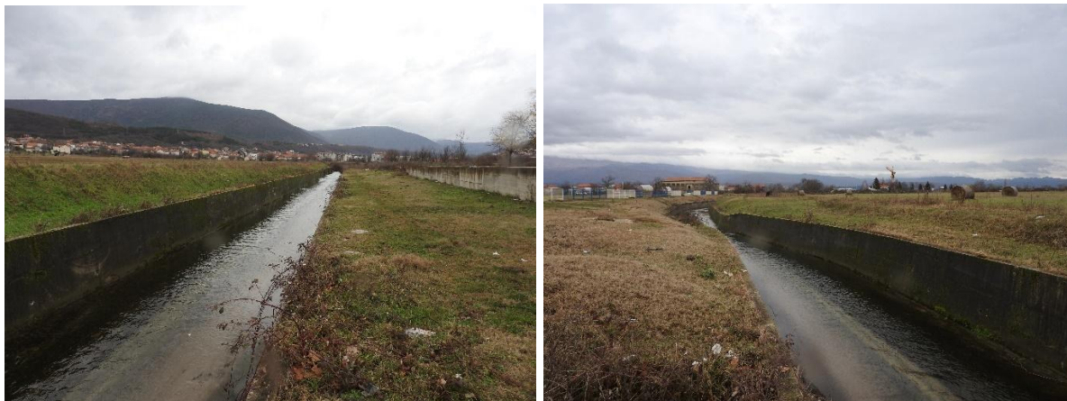
Fotografije C-44: Prikaz kanaliziranog stalnog vodotoka (stacionaža 0+731)
