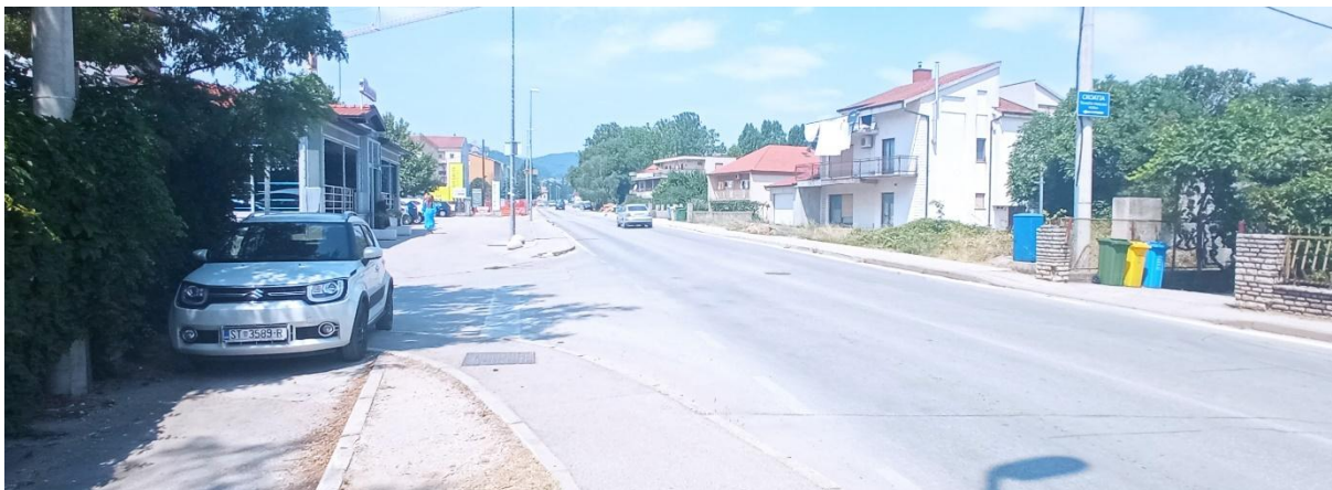
Fotografija A-3: Raskrižje 6 u km 1+015, lokalna cesta LC67040, Varijanta 3
