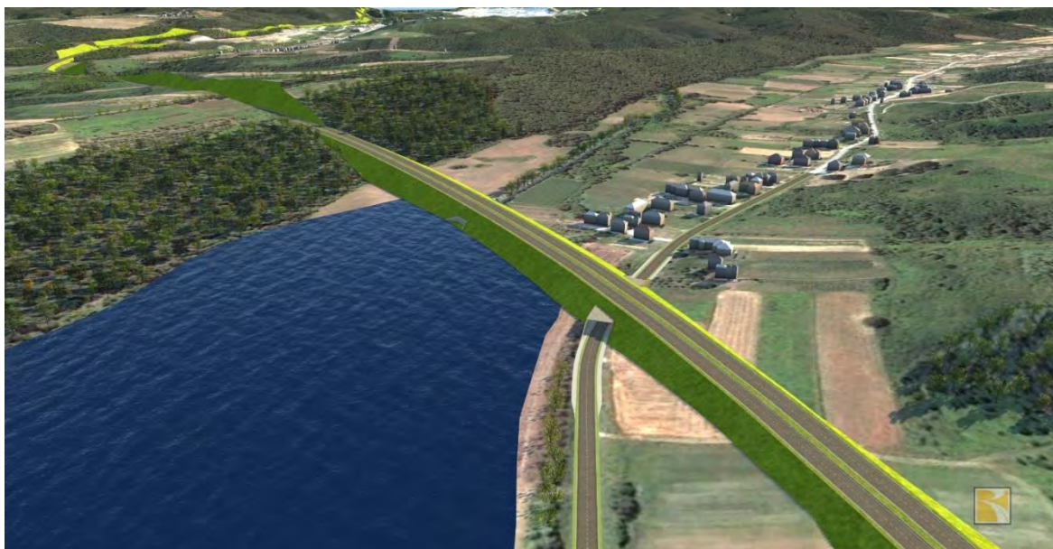
Slika 2.2. Varijanta s izvedbom nasipa i putnog prolaza
