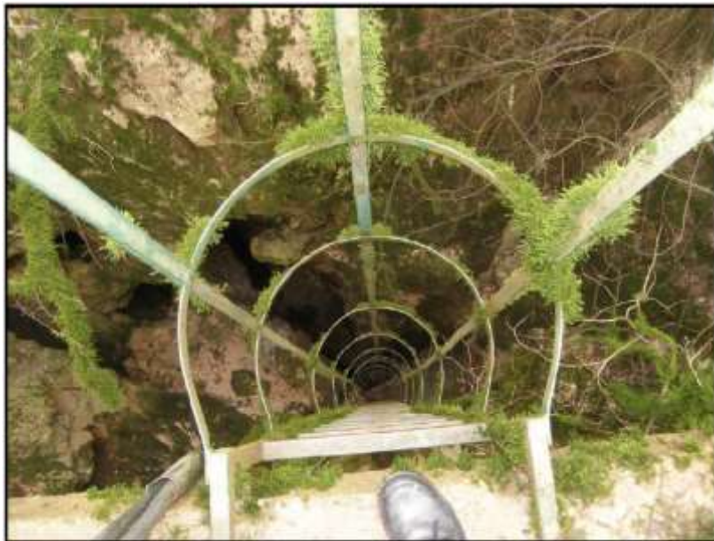
Fotografija A-2: Postojeće metalne ljestve s leđnom zaštitom u estaveli Betina
