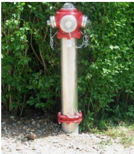
Grafički prikaz A-7: Nadzemni hidrant
