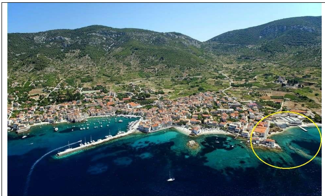
Slika 2.1.2. Prikaz postojećeg stanja
