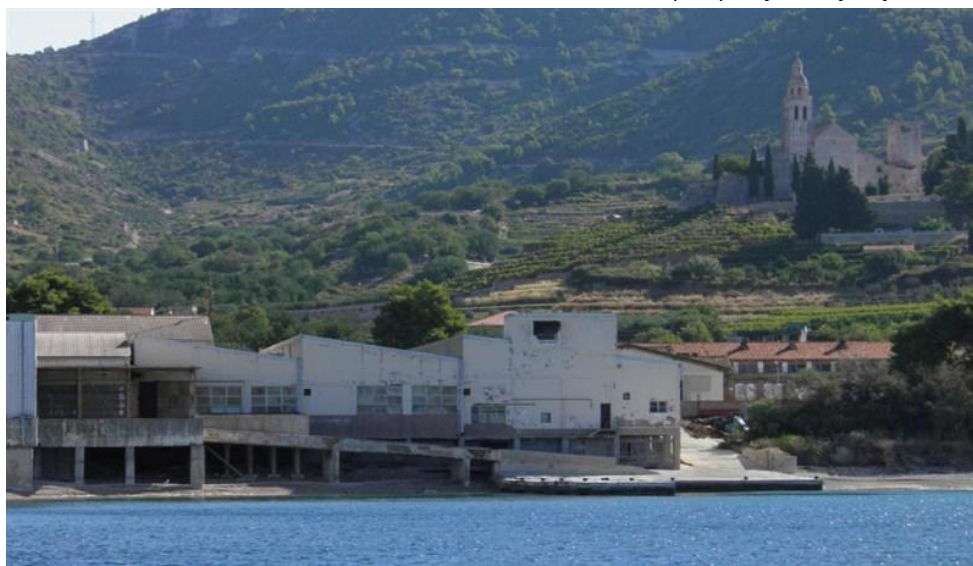
Slika 4.8.1. Tvornica „Neptun“ – ostaci objekata
