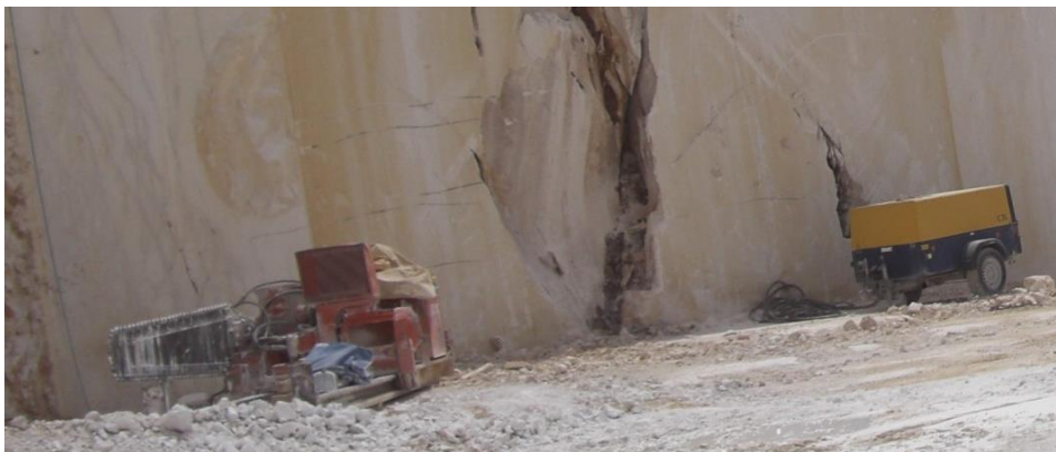
Slika 1./7. Lančana sjekačica i diesel agregat [31]
