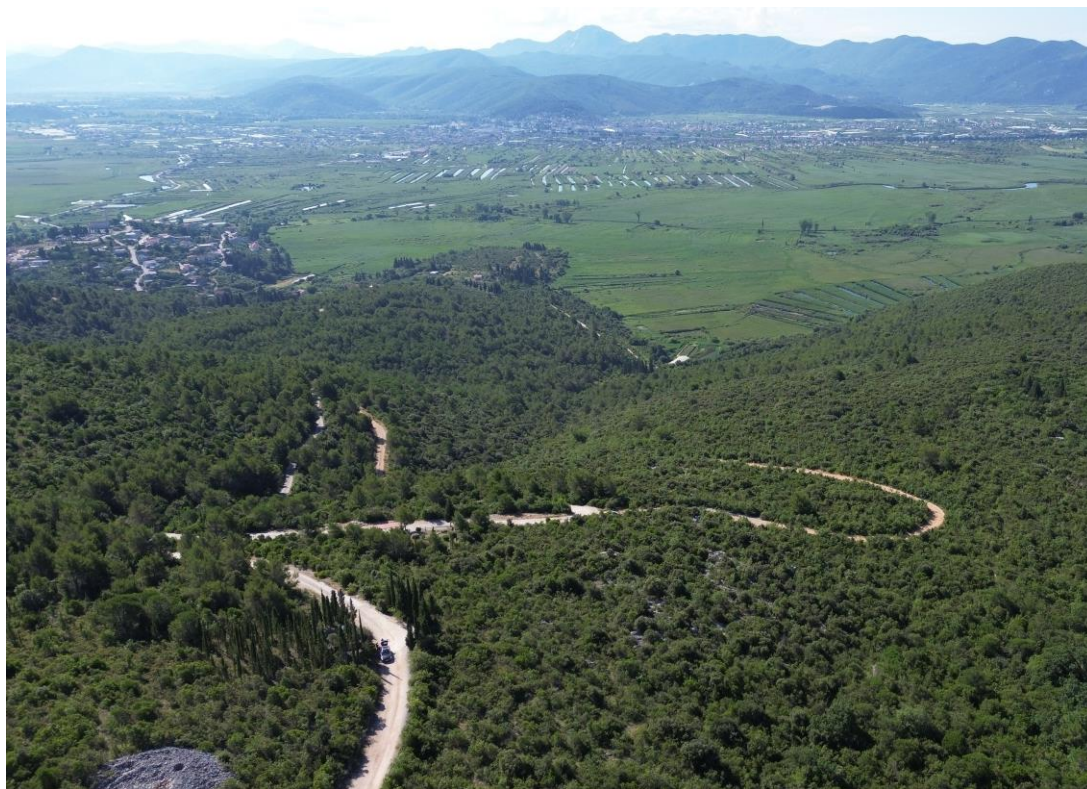
Slika 4.3-48 Pogled na lokaciju trase priključnog kabela iz zraka (u koridoru nerazvrstane ceste na pobrđu; te županijske ceste ŽC-6218 na području Vida i doline Neretve – sasvim lijevo)
