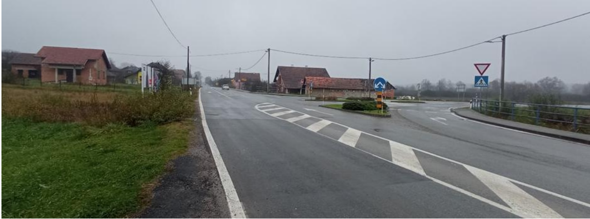
Fotografija A-1: Raskrižje 1-početak zahvata (0+000 km)
