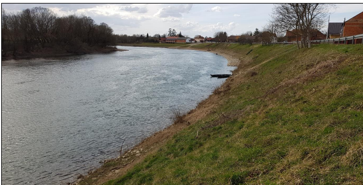
Slika 65. Lokacija postojeće obaloutvrde – pogled uzvodno
