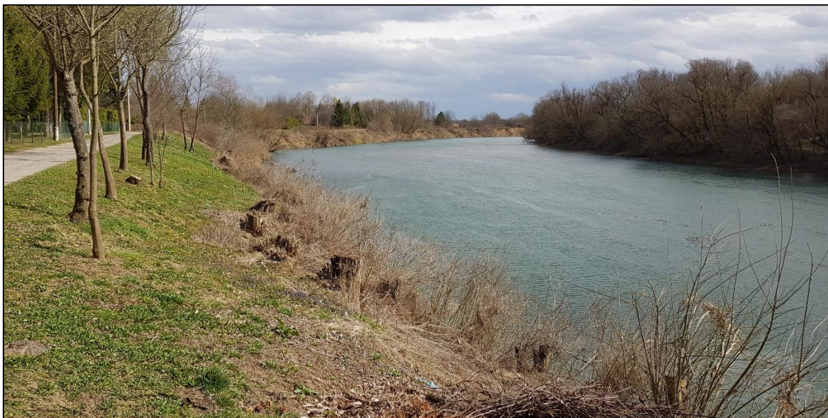
Slika 64. Lokacija planirane obaloutvrde – pogled nizvodno
