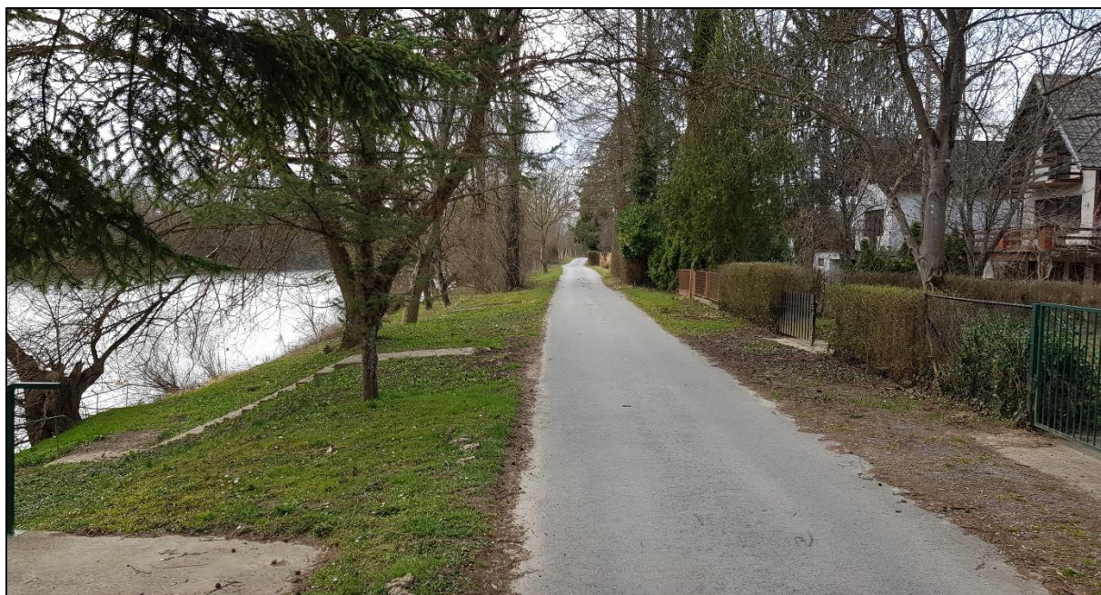
Slika 60. Kupa između Starog Farkašića i Starog Broda, pogled uzvodno
