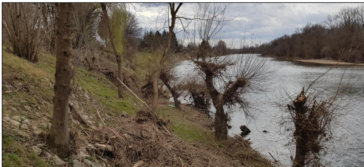
Slika 67. Lokacija planirane obaloutvrde – pogled nizvodno
