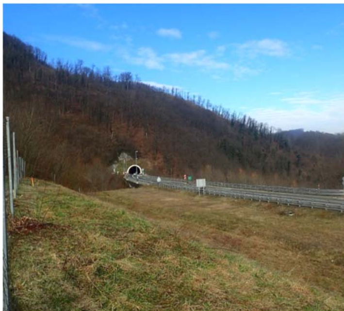
Slika 3.10-2 Pogled prema sjeveru na trasu autoceste (stac. 41+750), između dva tunela
