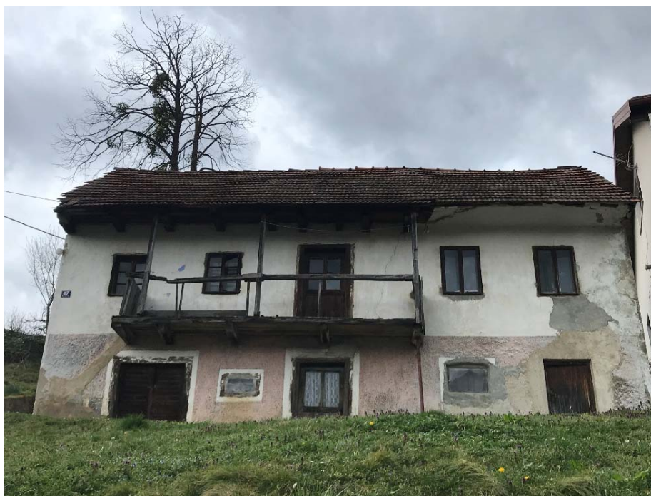
Slika 3.11-9 Stambena građevina, Doliće 47
