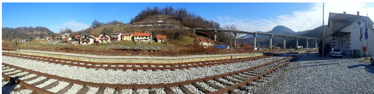
Slika 3.10-3 Pogled na vijadukt Ravnišćica i željezničku postaju u Đurmancu
