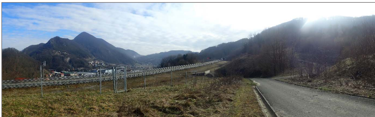
Slika 3.10-1 Pogled prema jugu na trasu autoceste (stac. 41+750), između dva tunela
