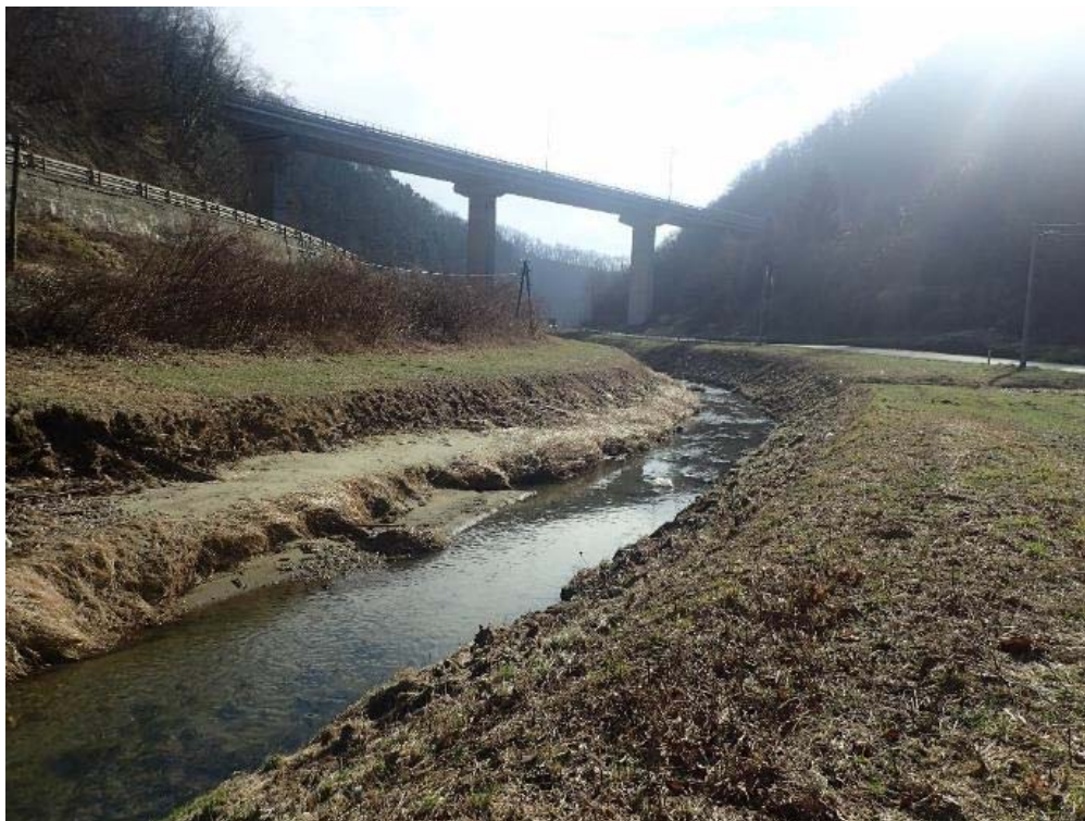
Slika 3.6-3. Šumsko stanište oko vijadukta „Puhi“ i vodotok Krapinica ispod vijadukta. (Autor: Oikon d.o.o.)
