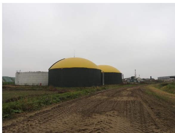
Fotografija A-8: Lokacija 8; silosi kod stacionaže 2+400
