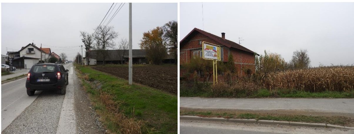
Fotografija D-1: Kuće u naselju Stare Plavnice kod stacionaže 3+407
