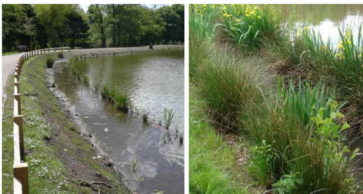
Slika 15. Primjer stabilizacije obale metodom „coconut fiber roll“
