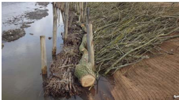
Slika 14. Primjer stabilizacije obale metodom „brush mattress“
