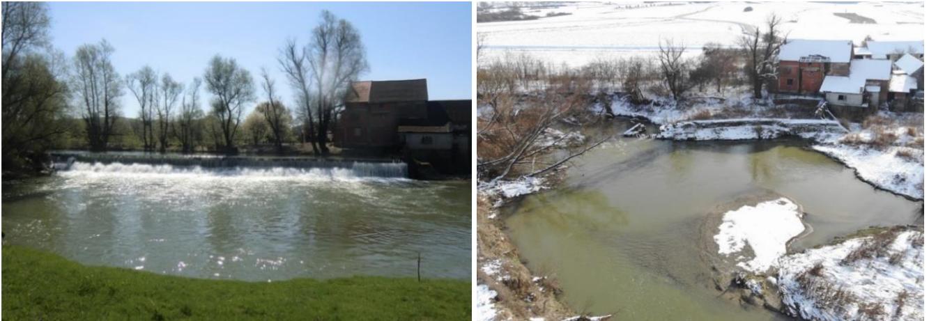
Slika 2.4 Prikaz stanja male hidroelektrane prije i nakon pucanja brane (2015. i 2021. godina)
