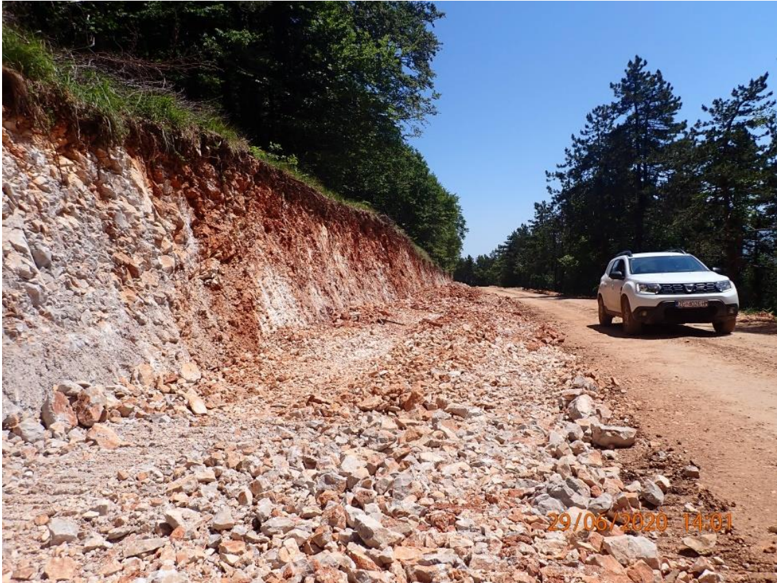
Slika 11 Novoizgrađena pristupna cesta za montažu vjetroagregata sa strmim stranicama
