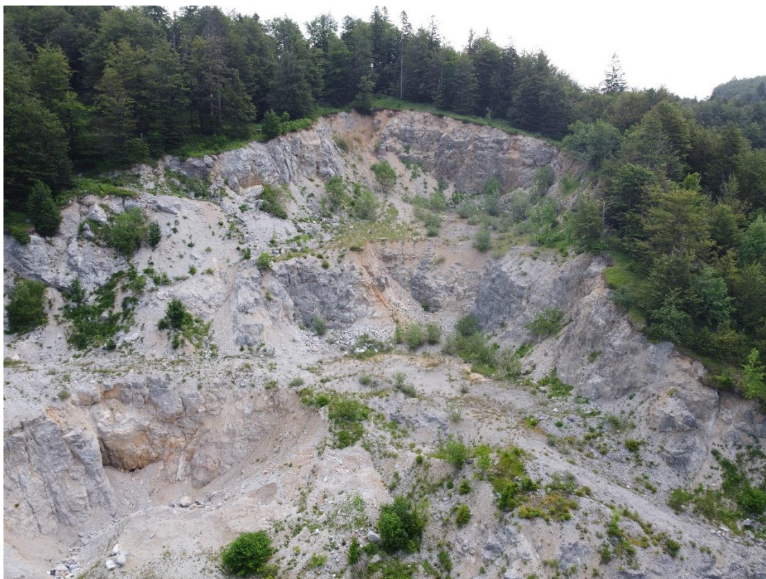
Slika 1./4. Postojeće stanje – pogled P3 [30]
