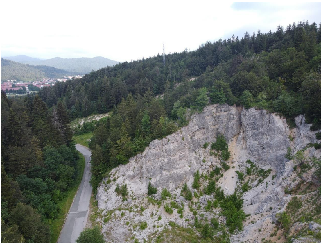
Slika 1./2. Postojeće stanje – pogled P1 [30]
