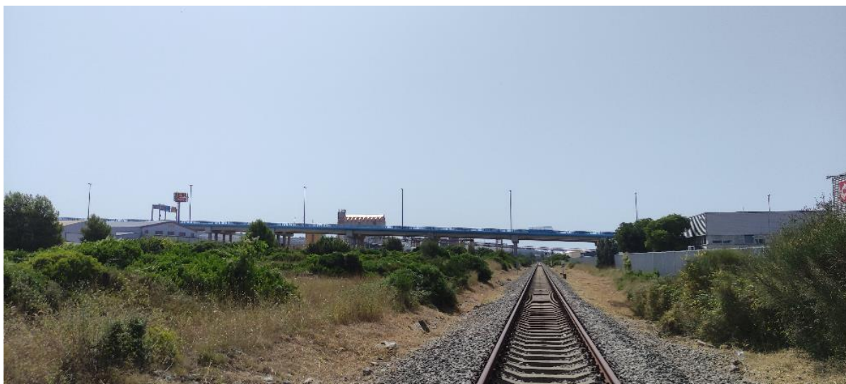
Slika 3.12-6. Završetak rekonstrukcije (foto Oikon d.o.o., srpanj 2023.)
