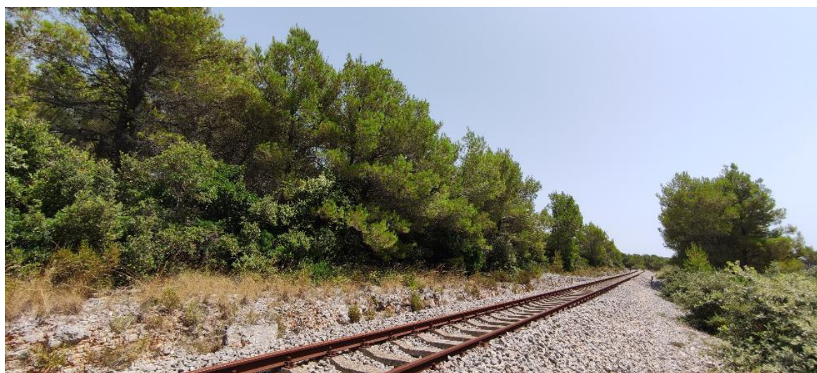
Slika 3.12-3. Postojeća trasa pruge s karakterističnim površinskim pokrovom koji zaklanja vizuru na trasu planirane pruge (foto Oikon d.o.o., srpanj 2023.)
