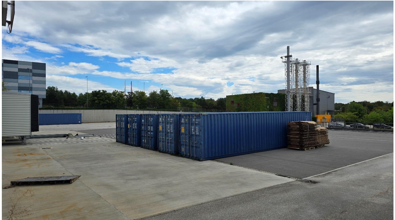
Slika 1.4 Asfaltirane prometne površine
