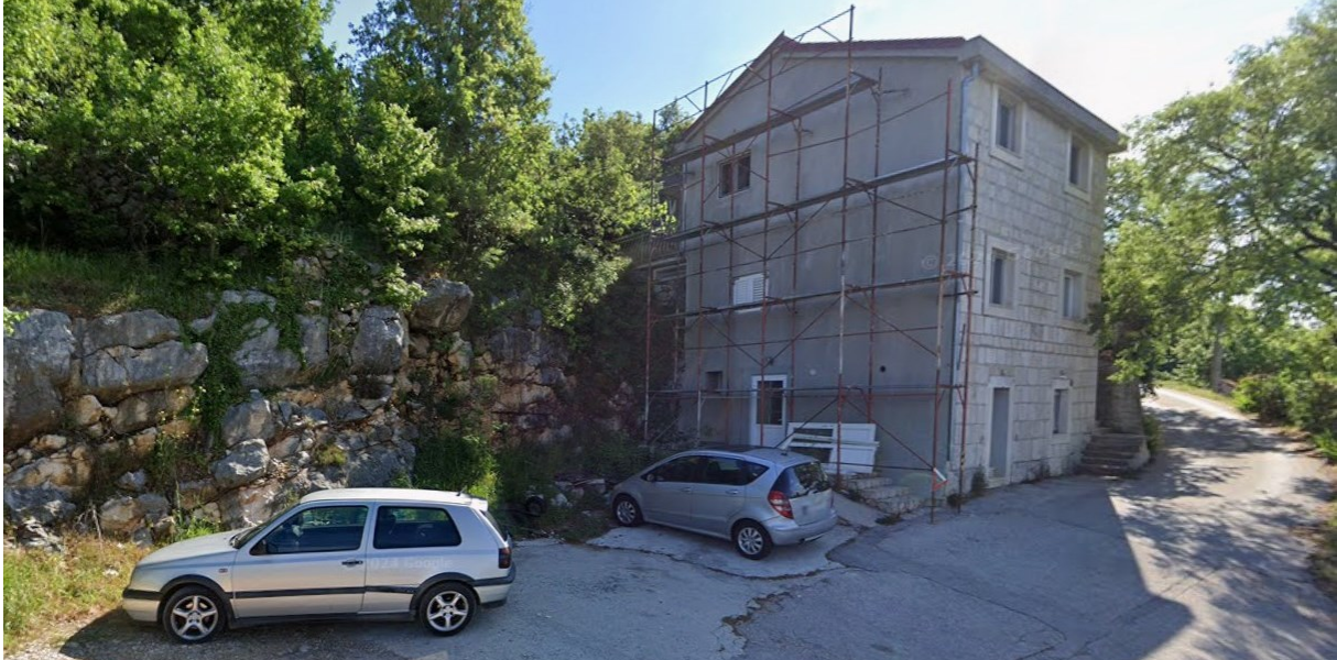
Slika 5.15. Lokacija zahvata u stambeno-poslovnoj zgradi građevinskog područja izvan naselja (izvor: google.maps)
