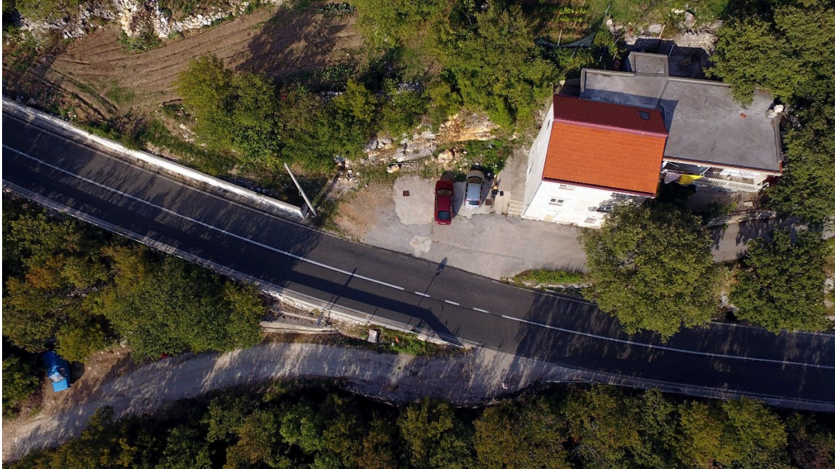
Slika 2.3. Lokacija zahvata unutar postojeće stambeno-poslovne zgrade Vukušić na dijelu k.č. 4297/1 k.o. Katuni,, a na čijoj je adresi registriran postojeći pogon za preradu, skladištenje i veleprodaju širi prikaz lokacije
