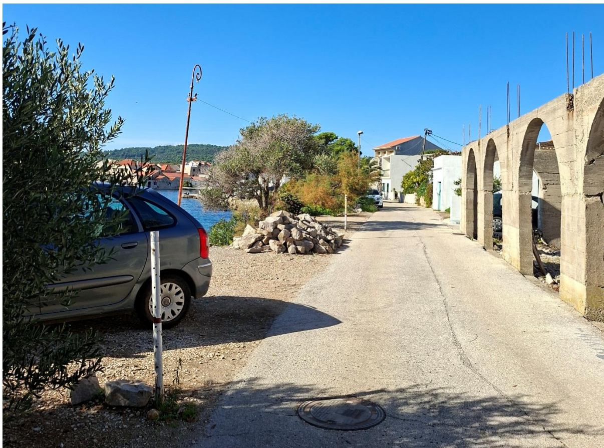
Slika 1. 1 - 7 Prikaz lokalne prometnice u zaleđu zahvata (Izvor: Zeleni servis d. o. o., 31.10.2025.)
