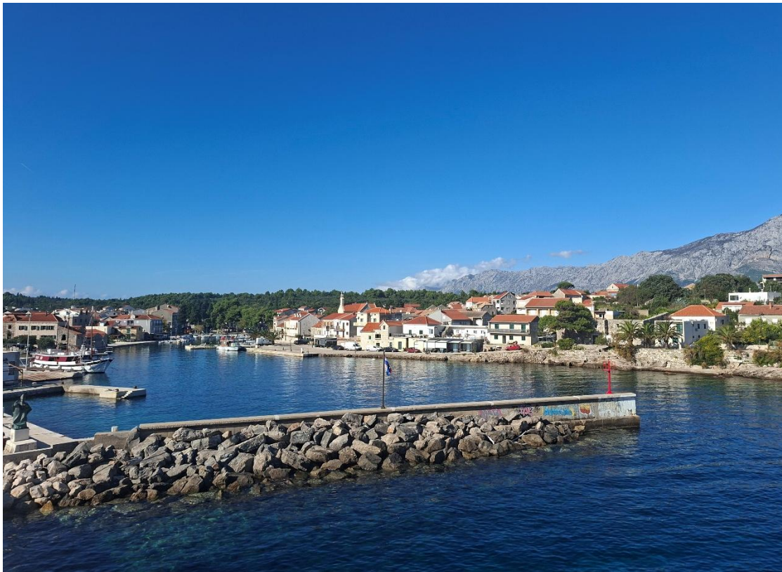
Slika 1. 1 - 2 Prikaz lukobrana unutar luke (Izvor: Zeleni servis d. o. o., 31.10.2025.)
