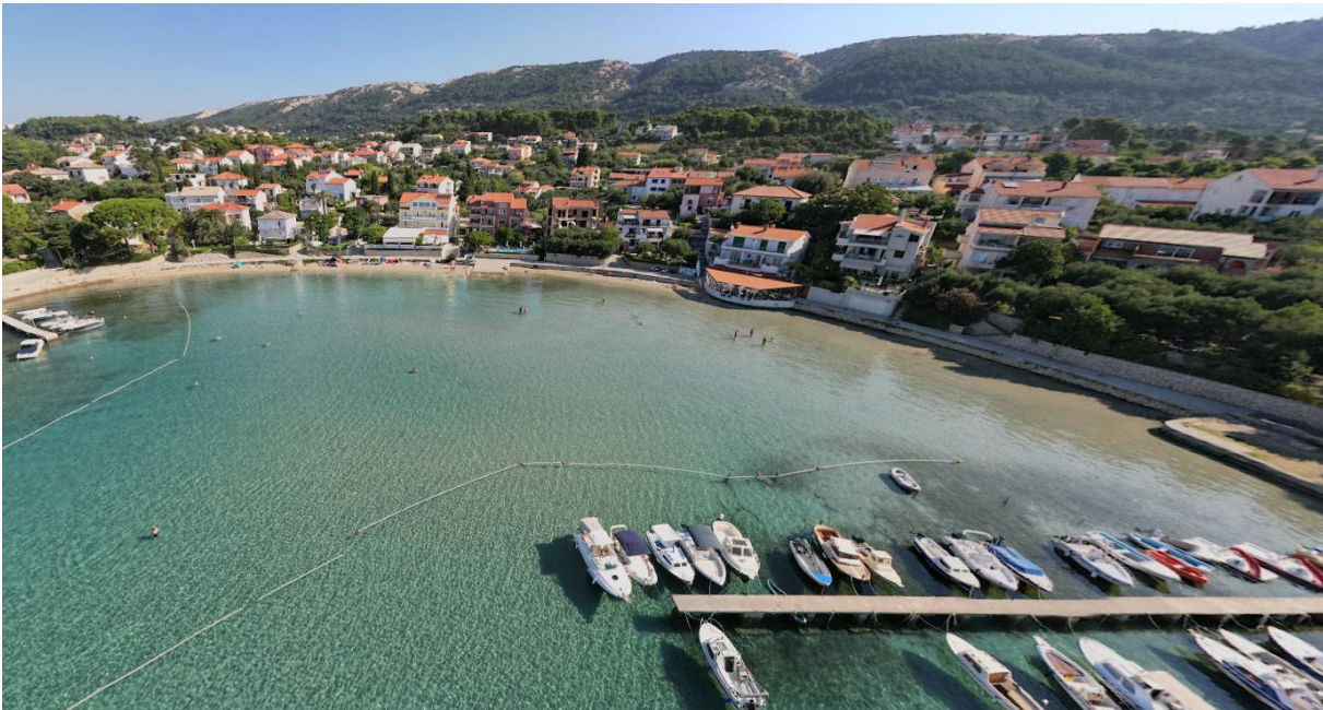
Slika 6.2.1. Pogled na uvalu Padova II – postojeće stanje
