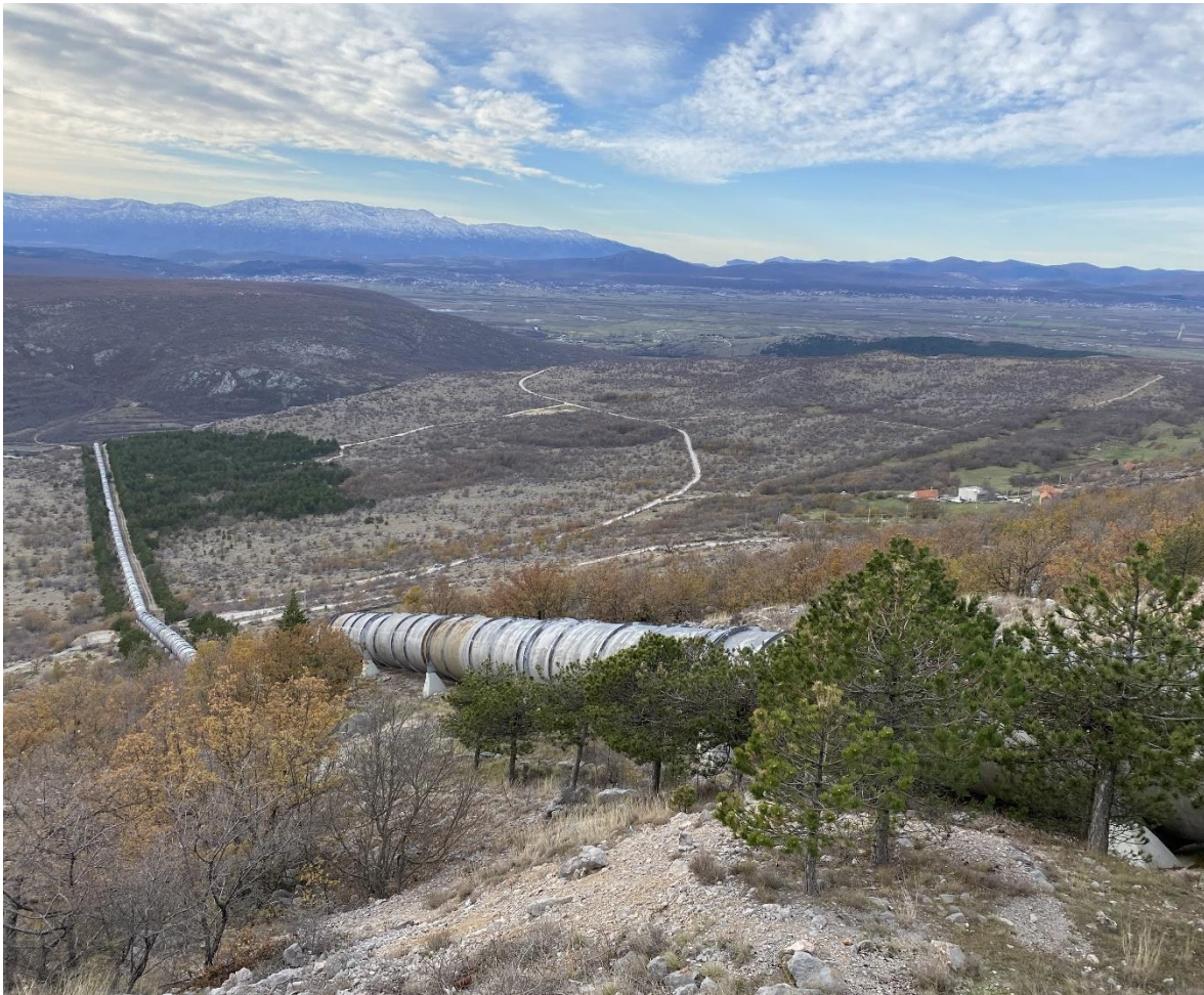
sl. 2.4.25: Pogled na tlačni cjevovod od zasunske komore prema strojarnici GHE Orlovac
