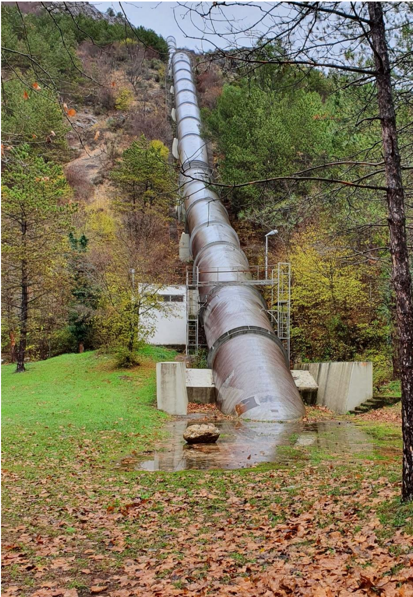
sl. 2.4.24: Donji dio tlačnog cjevovoda
