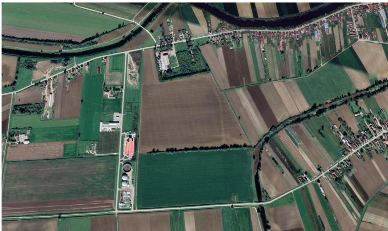
Slika 41. Uža lokacija zahvata, pogled iz zraka
