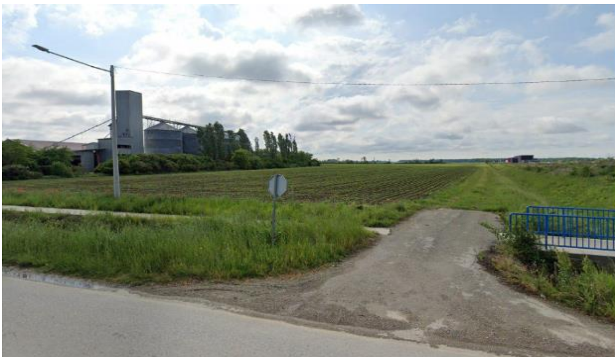
Slika 3. Pogled na lokaciju zahvata sa sjevera (Izvor: Idejni projekt, ISG d.o.o.)
