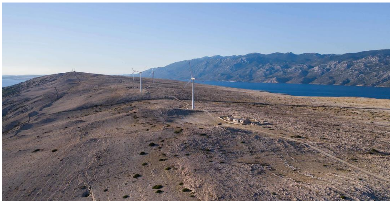
Slika 2.2-4 Pogled na postojeću VE Ravne 1 s predjela JI od vjetroelektrane (izvor: web portal AdriaPress.hr)
