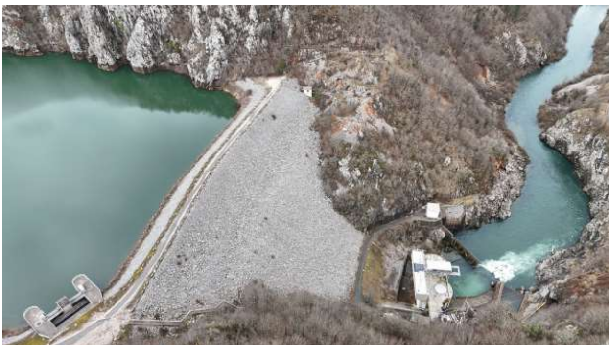
Slika 2.14/5 – Akumulacija Kruščica, brana i HE Sklope, rijeka Lika
