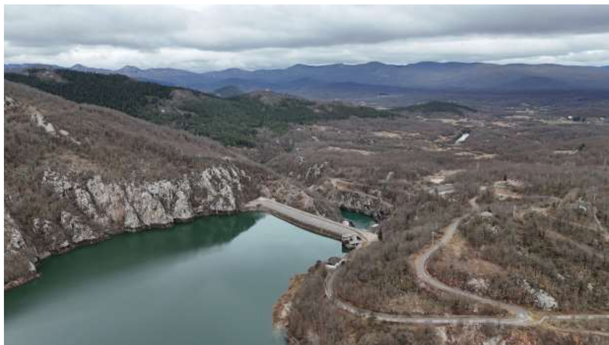
Slika 2.14/3 – Akumulacija Kruščica s branom i HE Sklope
