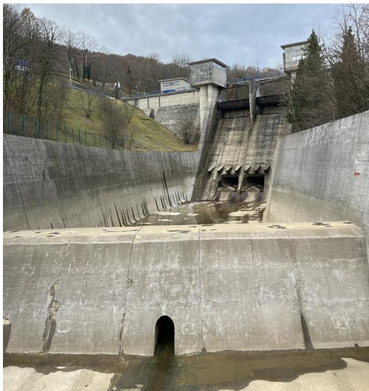
Slika 8 Brana Valići – nizvodno (08. prosinac 2023.)
