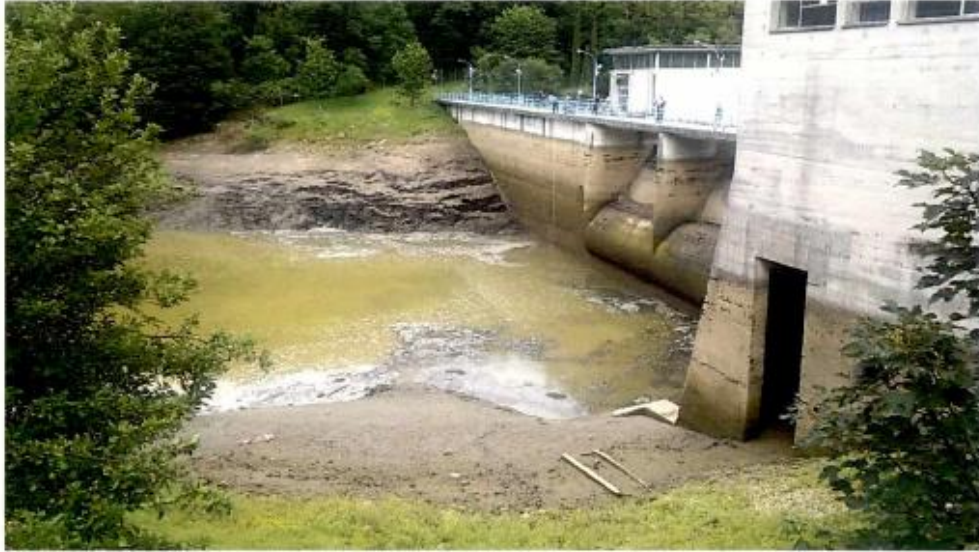
Pražnjenje akumulacije Valiči - I. dan (05.07.2014.)
