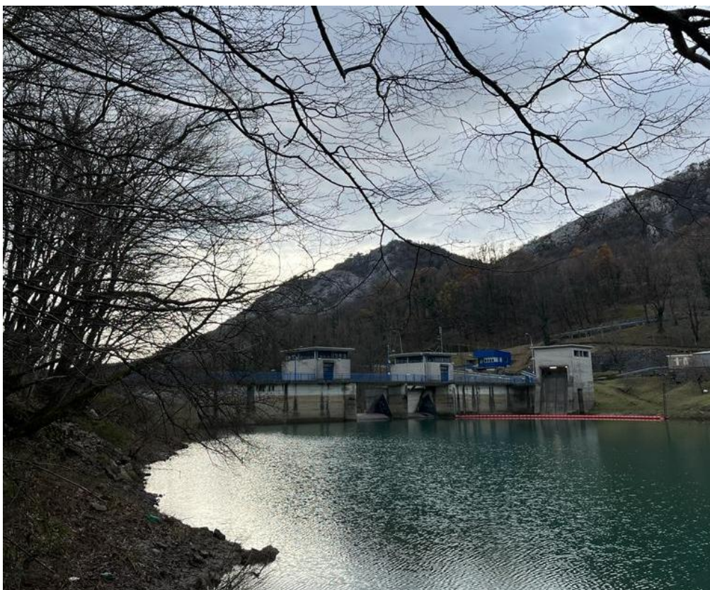
Slika 7 Brana Valići – uzvodno (08. prosinac 2023.)
