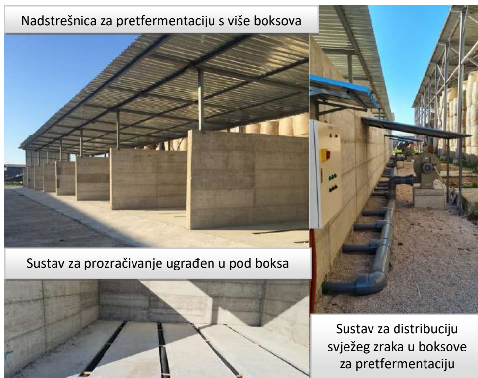
Slika 11. Primjer prostora za pretfermentaciju s boksovima (Izvor: Kohshin Ltd.)
