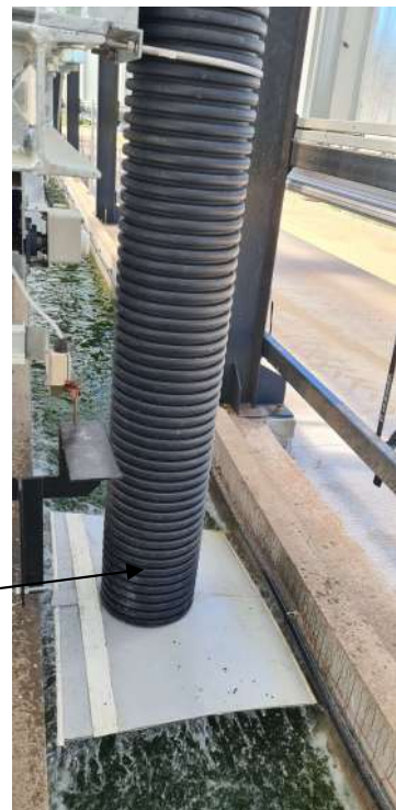
Kanal s vodom u koji se uvodi zrak iz cjevovoda na pročišćavanje
