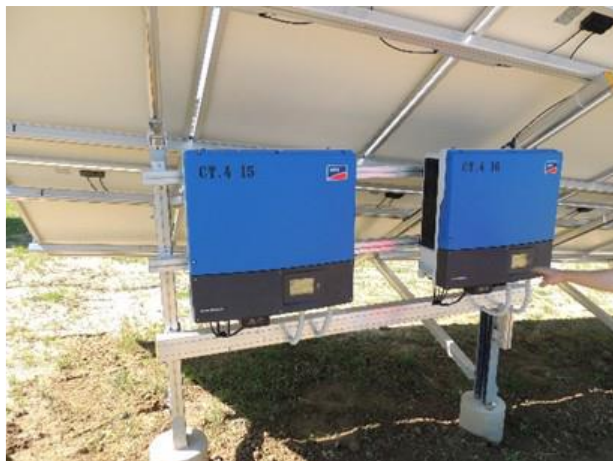
Slika 1.6 Koncept smještaja izmjenjivača male snage
