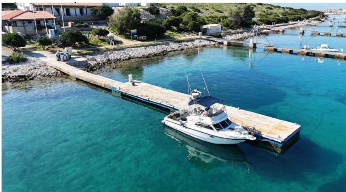
Slika 1. 1 - 1 Prikaz postojećeg stanja na području lokacije zahvata (izvor: Idejno rješenje)
