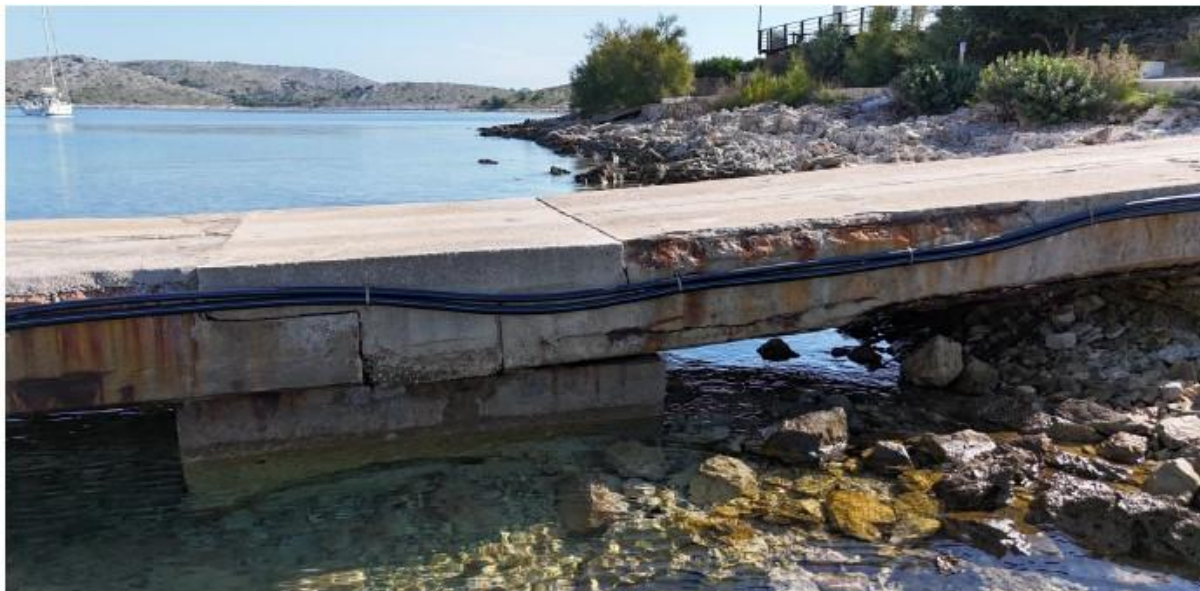
Slika 1. 1 - 2 Prikaz sjeverozapadne strane nosača pristupnog mosta (izvor: Idejno rješenje)
