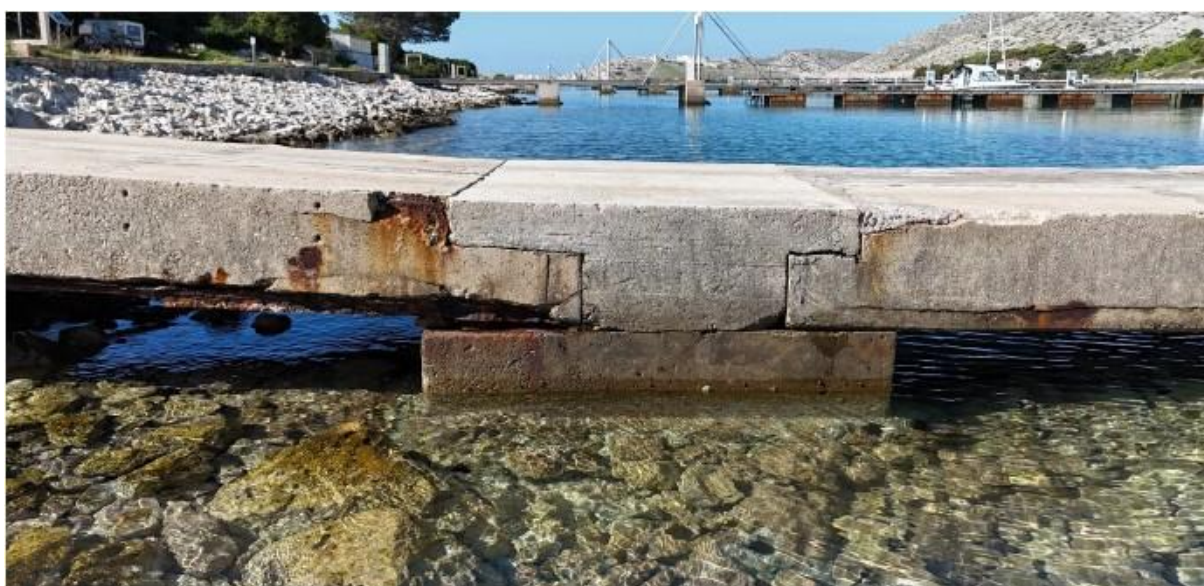
Slika 1. 1 - 3 Prikaz jugoistočne strane nosača pristupnog mosta (izvor: Idejno rješenje)
